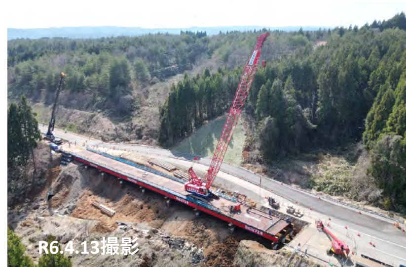
No.16付近 仮栈橋設置状況
