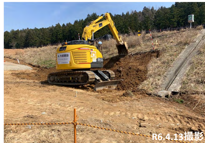
No.44付近 法面切土掘削状況
