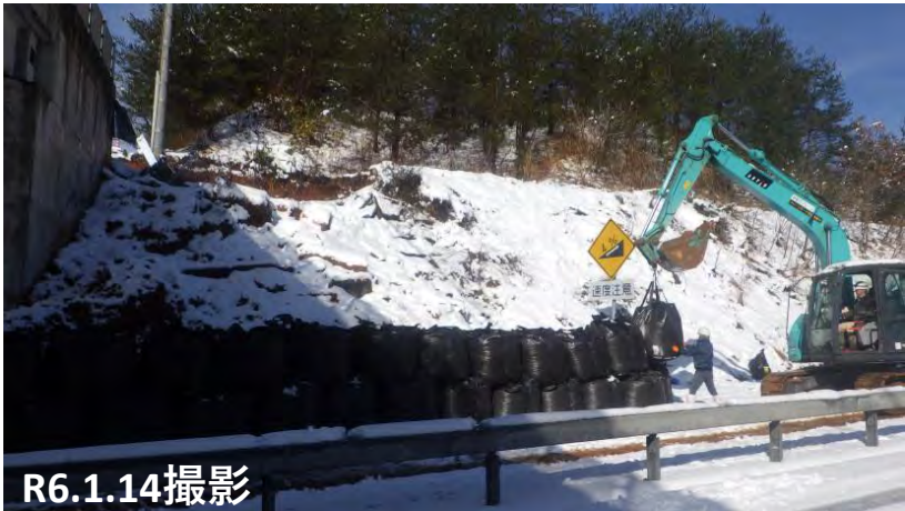
No.6 土嚢設置
