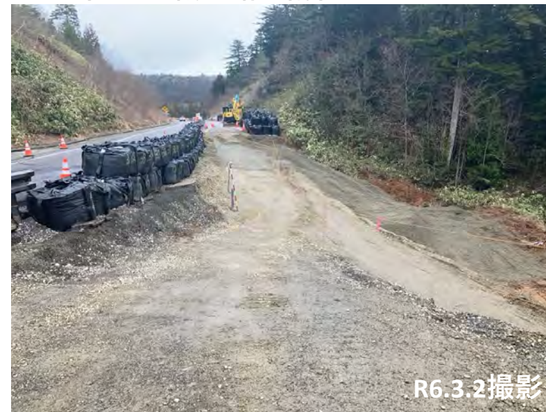
No.44付近 路盤不陸整正転圧状況
