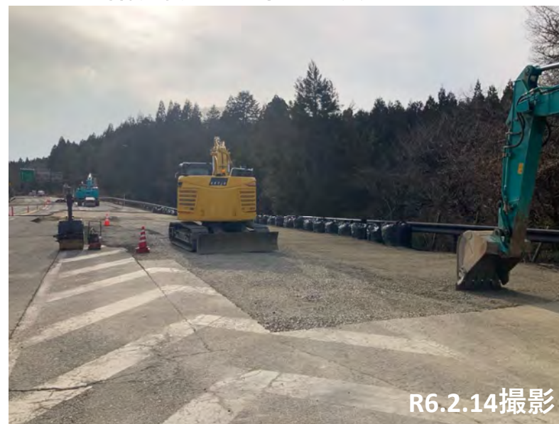
No.56 舗装撤去・砕石埋戻し
