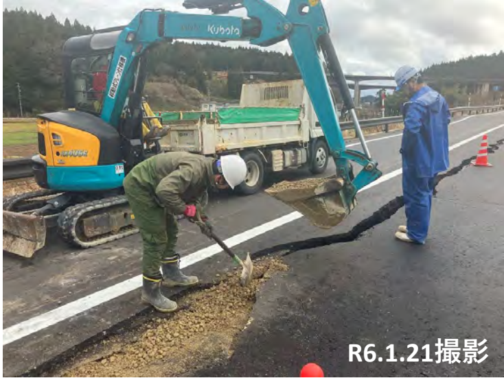
No41～42 段差復旧状況
