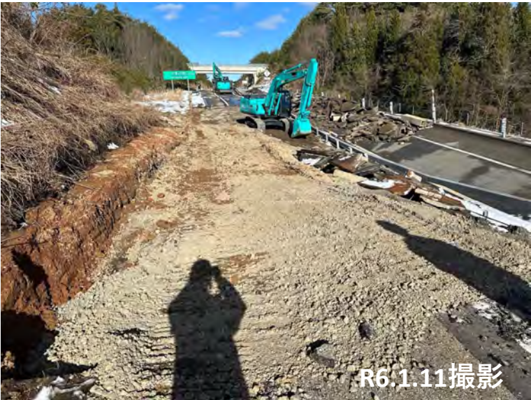
No.15 碎石充填状況
