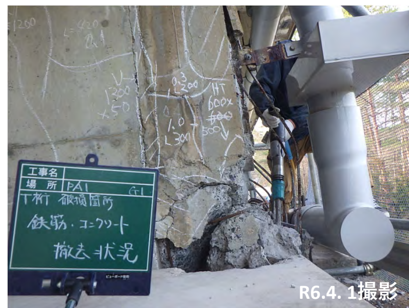
能登大橋・PA1橋台 鉄筋・コンクリート撤去状況
