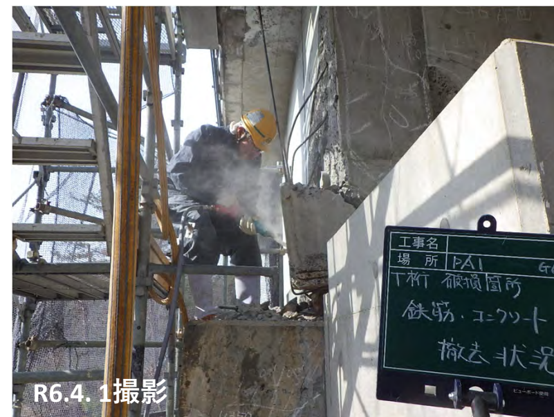
能登大橋・PA1橋台 鉄筋・コンクリート撤去状況
