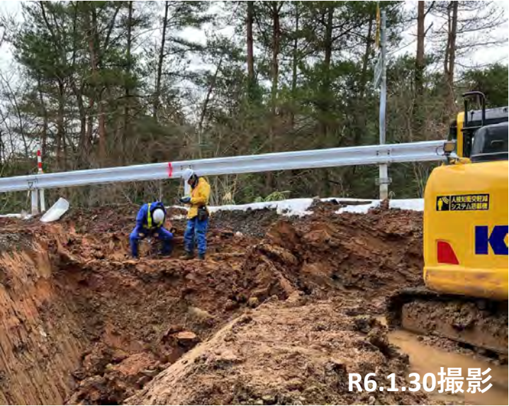
No.48詳細調査状況
