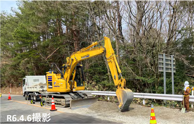
No.11 砕石敷均し状況
