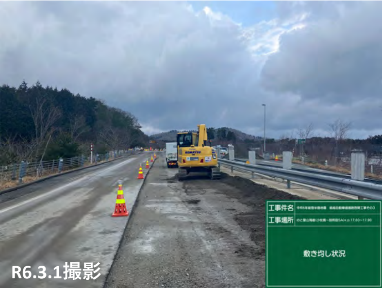
No.44 砕石敷均し状況
