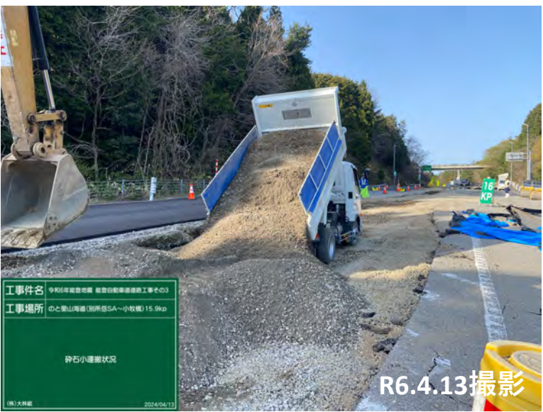
No.25付近 碎石小運搬状況
