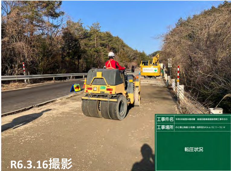
No.21 転圧状況
