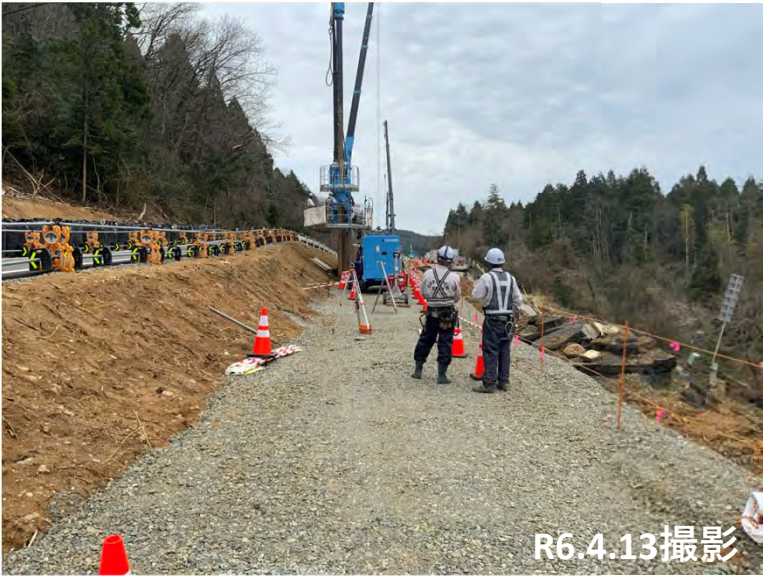
No.33付近 鋼矢板打設状況
