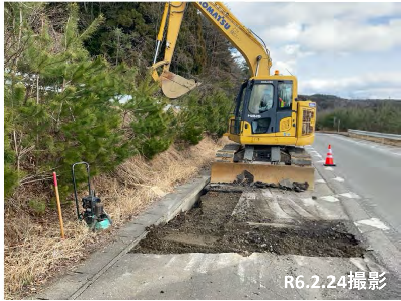
No.35 碎石敷均し状況
