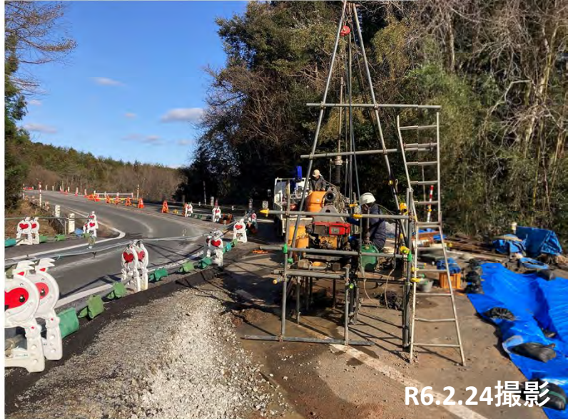
No.2 ボーリング調査状況
