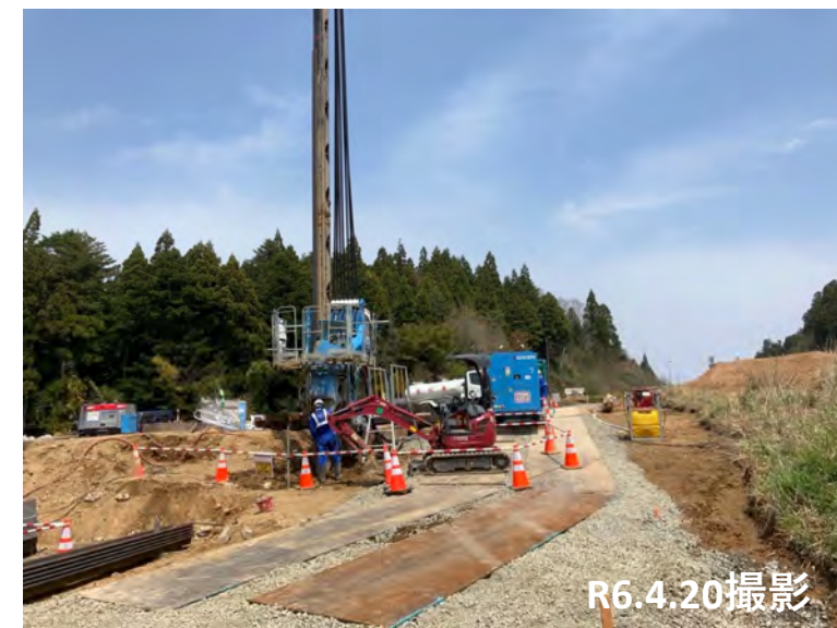
No.44付近 鋼矢板打設状況
