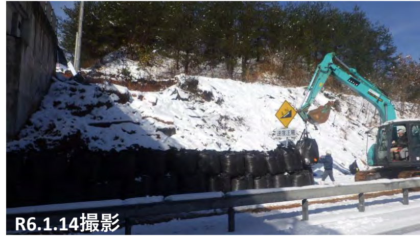
No.6 土嚢設置
