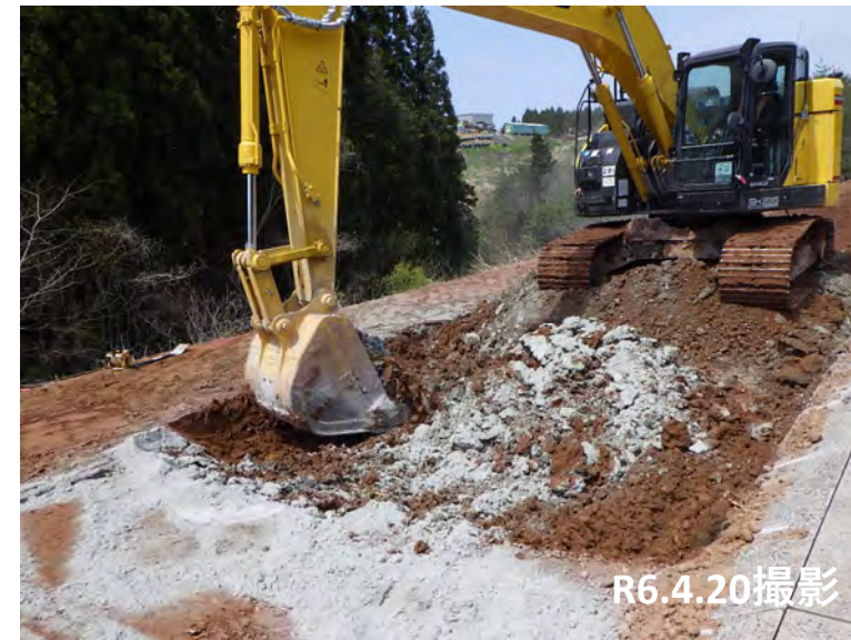
No.15付近 路床改良状況
