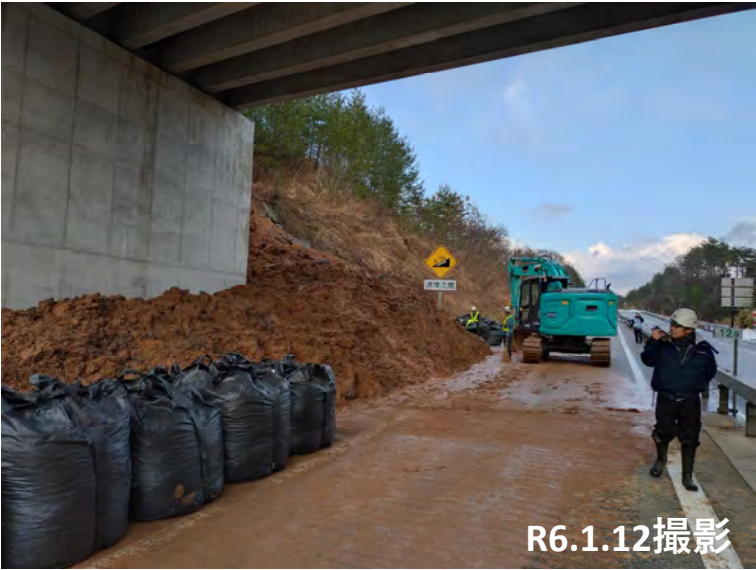
No.6 掘削・土嚢設置状況
