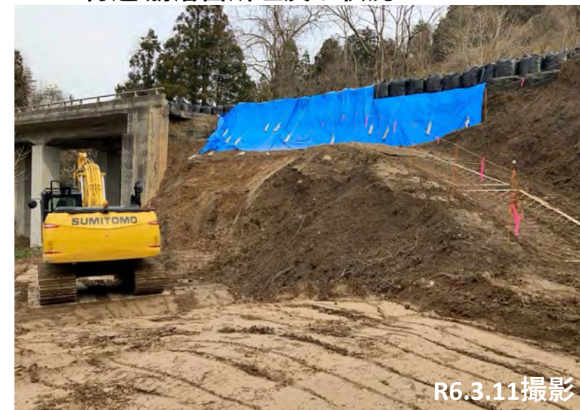
No.51付近 崩落箇所埋戻し状況
