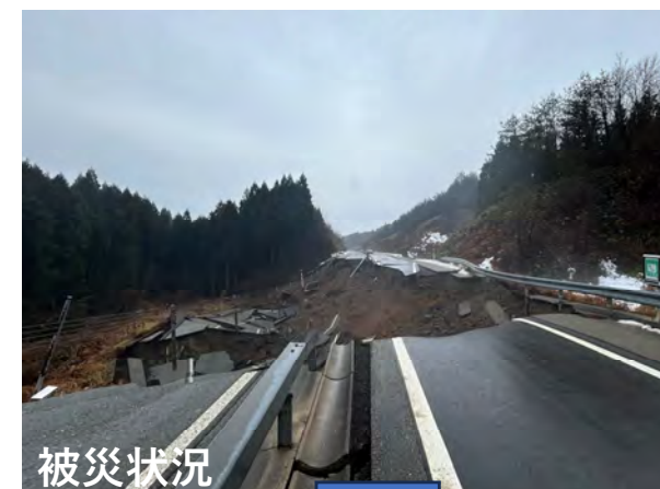
No16付近 1車線復旧完了
