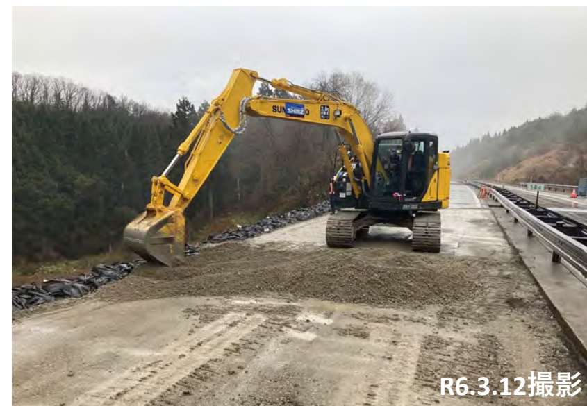
No.17 路盤材敷均し状況
