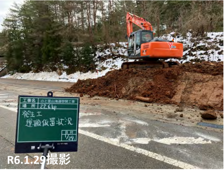
No.48～50詳細調査・残土処理状況
