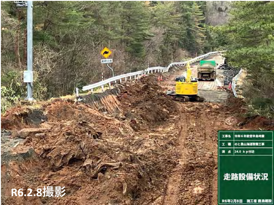
No. 47～50付近 走路整備状況
