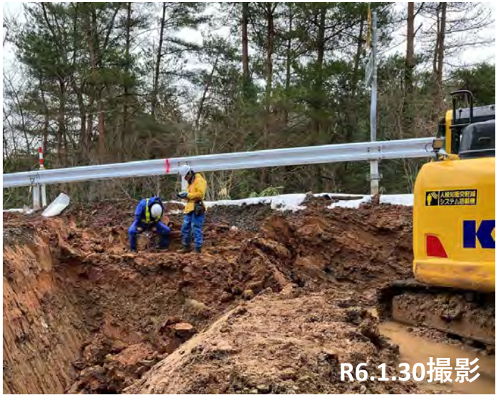
No.48詳細調査状況
