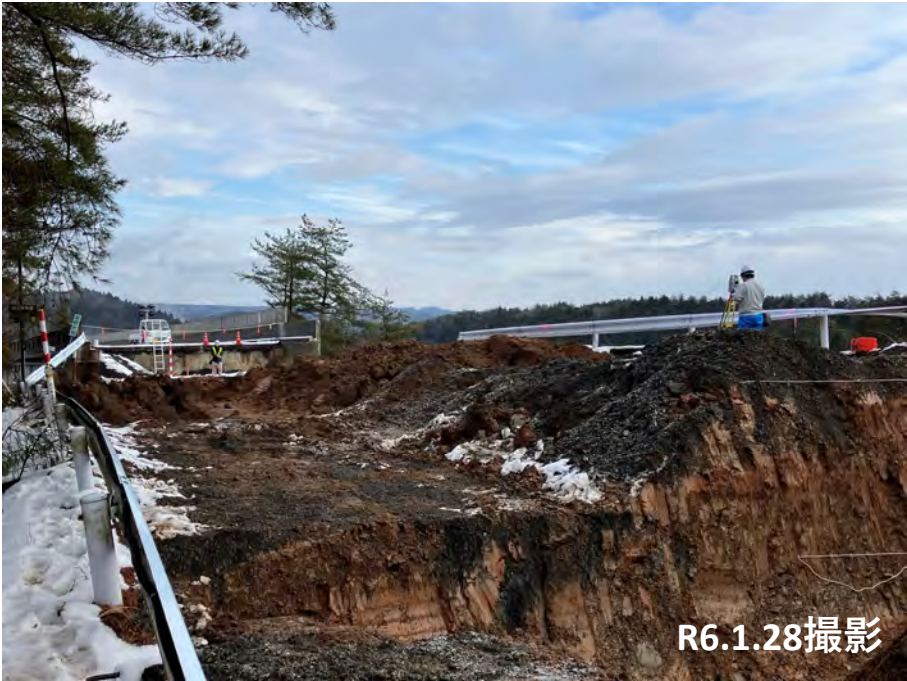
No.48測量状況
