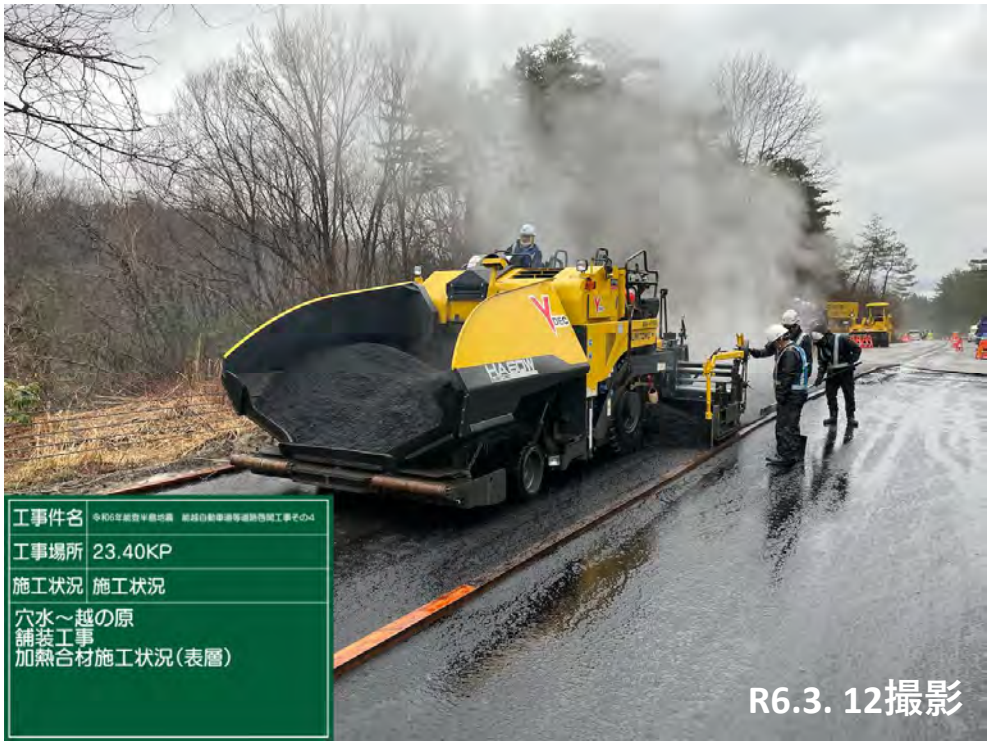
No. 40 舗装施工状況
