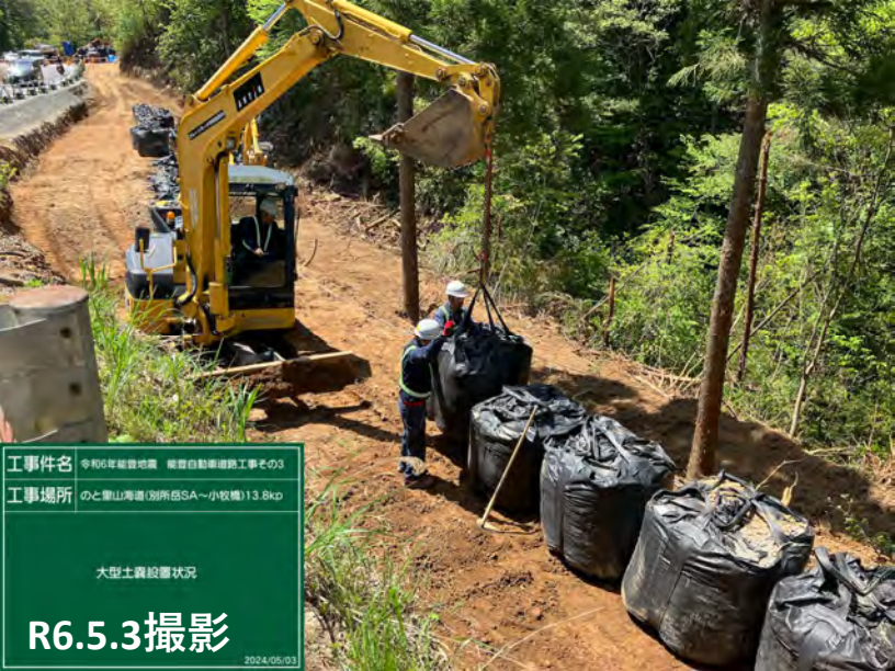
No.13 大型土嚢設置状況
