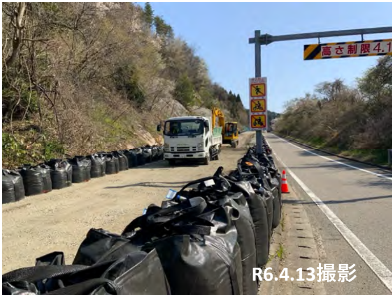
No.1付近 碎石敷均し状況
