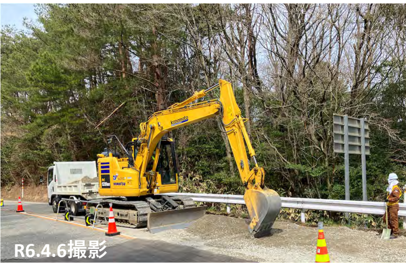
No.11 砕石敷均し状況
