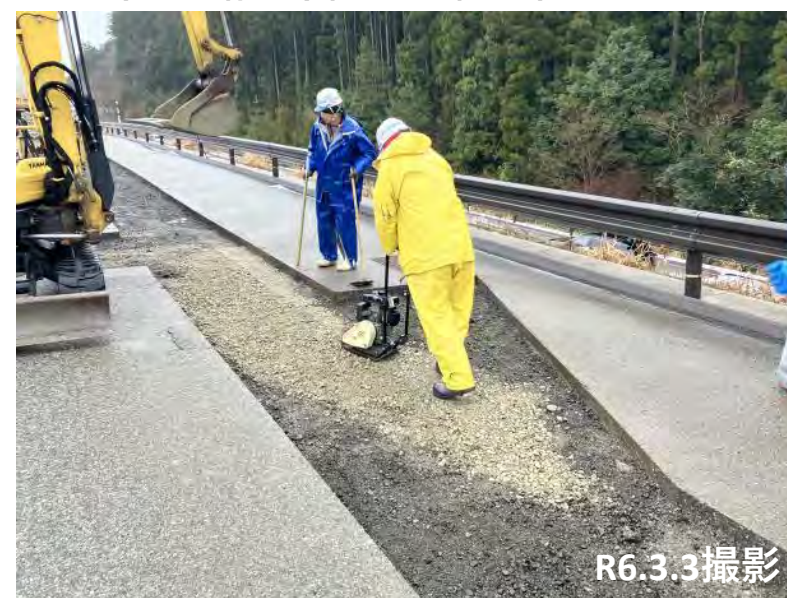
No.44付近 路盤不陸整正転圧状況
