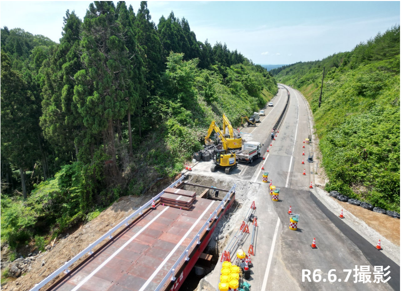
No.44付近 ガードレール設置状況
