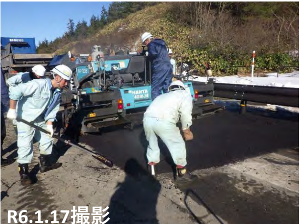
No.6 段差復旧状況
