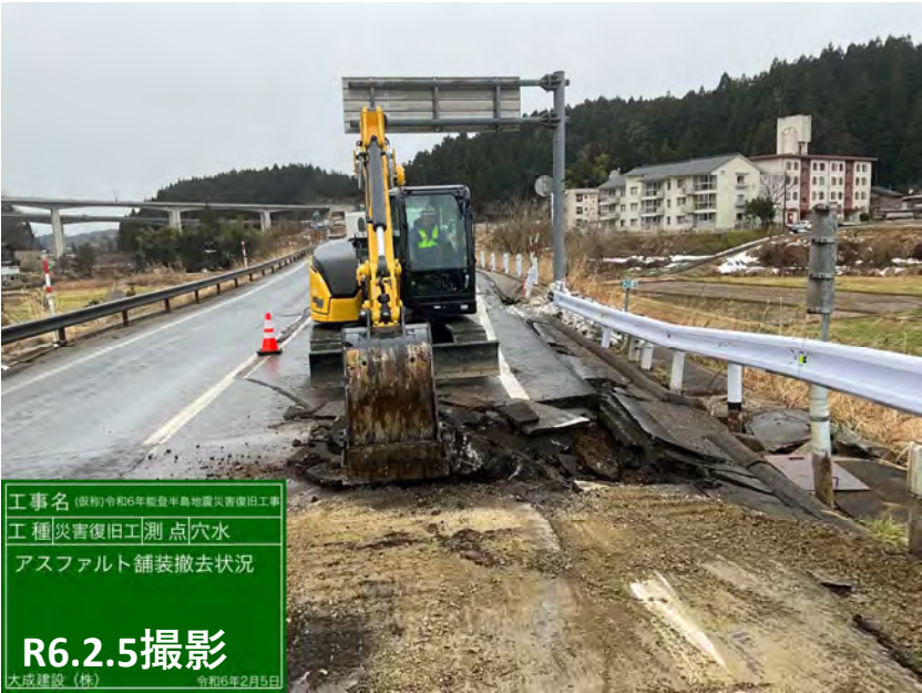
No.42付近 舗装撤去状況
