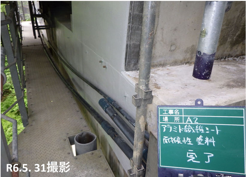
能登大橋・A2橋台 落橋防止断面修復状況
