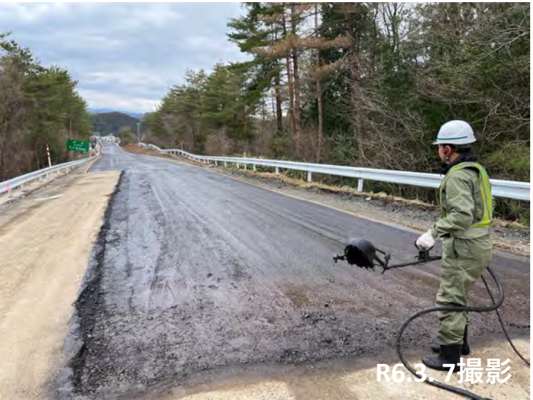
No. 45 舗装工乳剤散布施工状況
