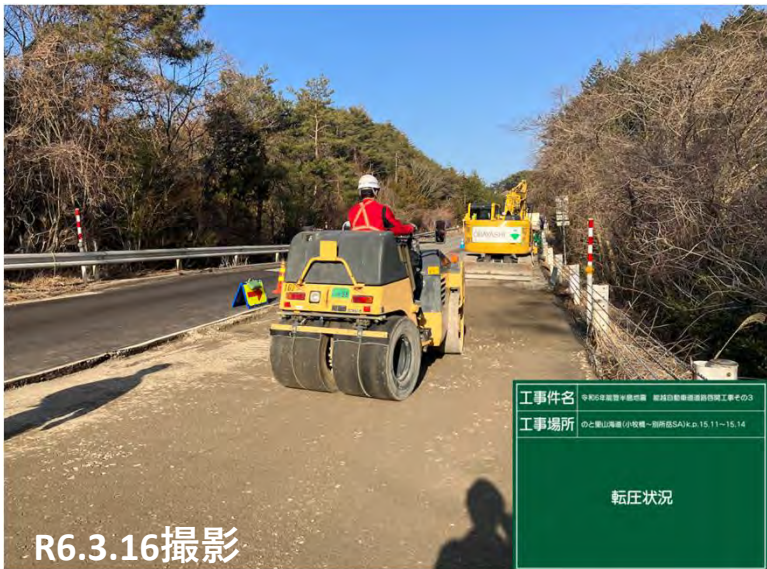
No.21 転圧状況
