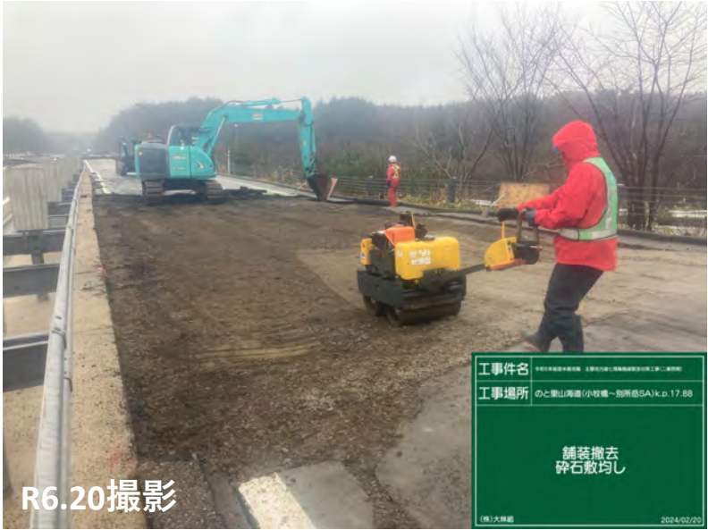
No.44 碎石敷均し状況
