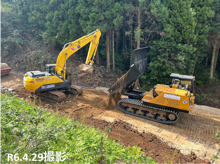
No.2付近 伐採材積込状況
