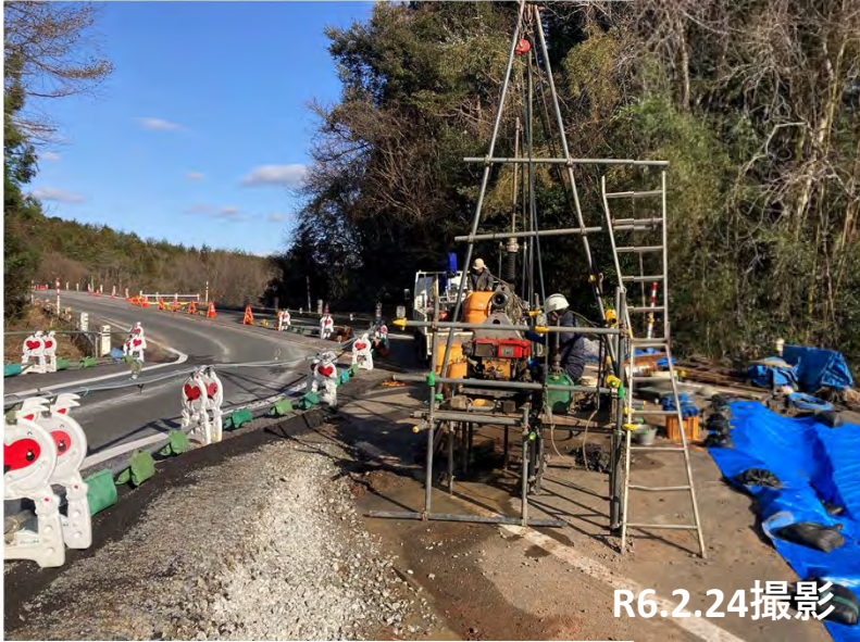
No.2 ボーリング調査状況
