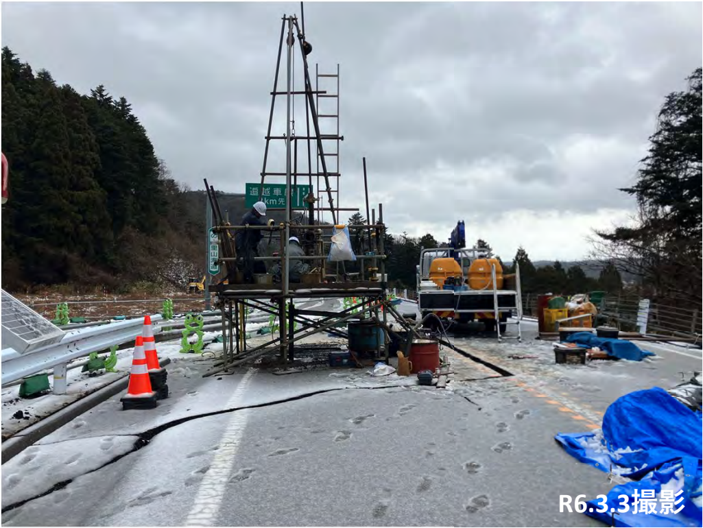
No.18 ボーリング調査状況
