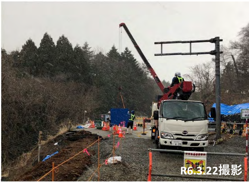
No.33 交通標識撤去状況
