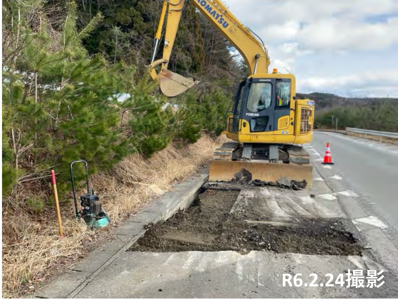
No.35 砕石敷均し状況
