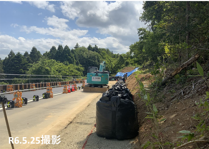
No.33 大型土のう設置状況
