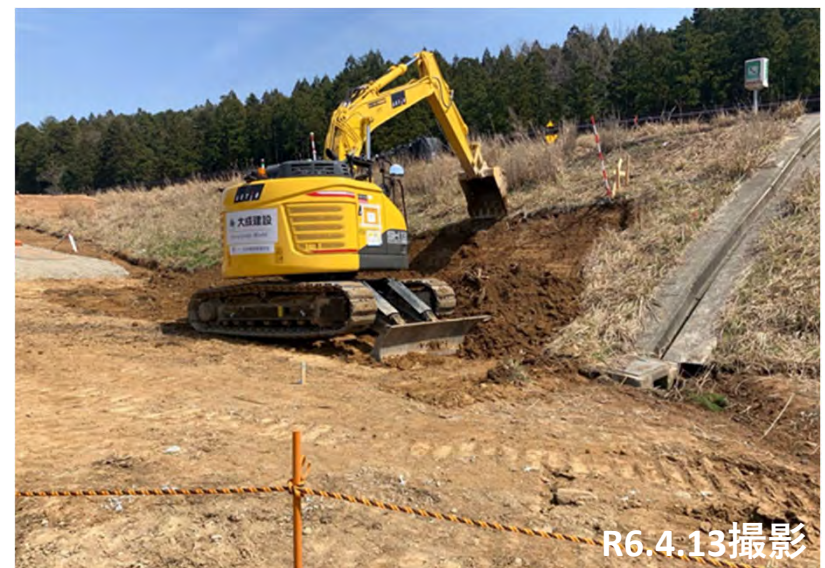
No.44付近 法面切土掘削状況
