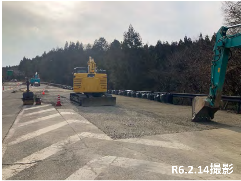
No.56 舗装撤去・砕石埋戻し
