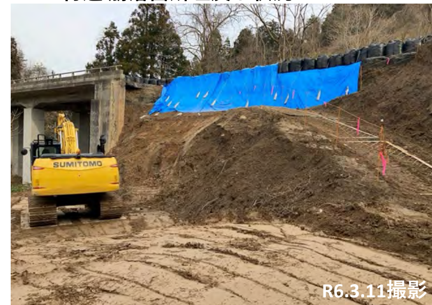
No.51付近 崩落箇所埋戻し状況
