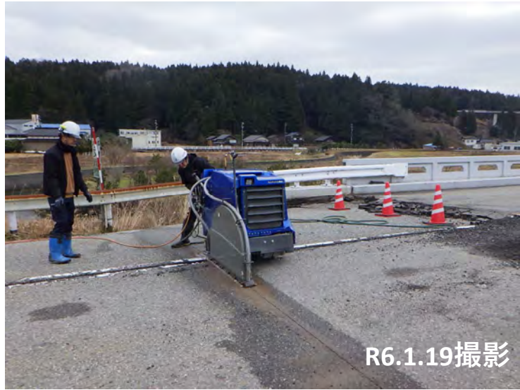
No.6 段差復旧状況
