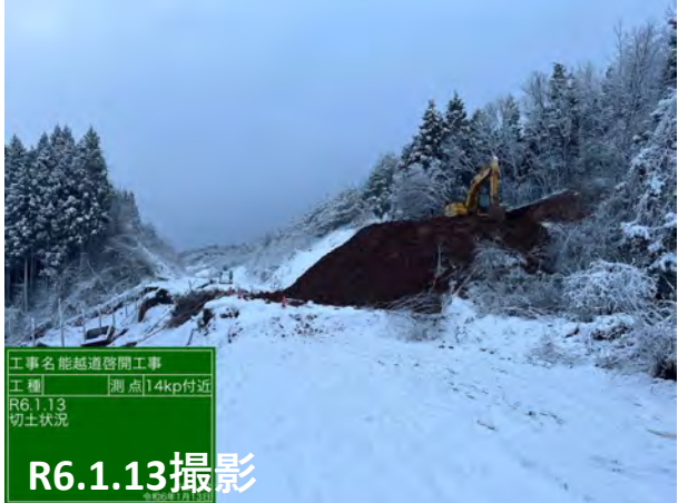
No.16 切土状況
