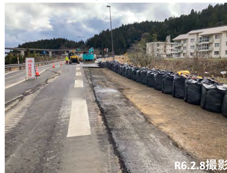
No.42付近 大型土嚢設置状況
