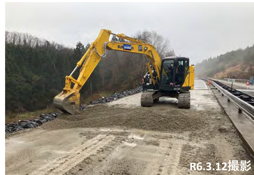
No.17 路盤材敷均し状況
