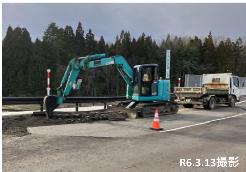
No.40付近 舗装撤去状況
