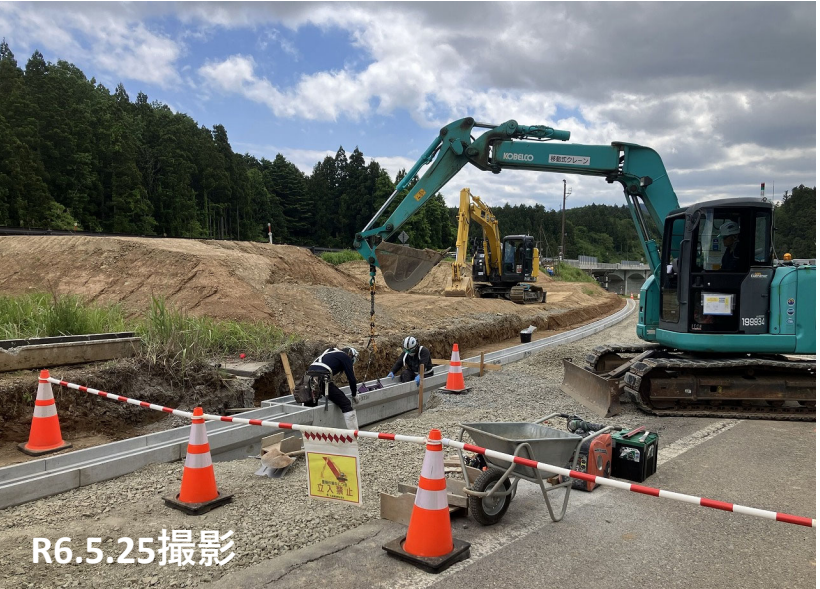
No.44付近 側溝設置状況
