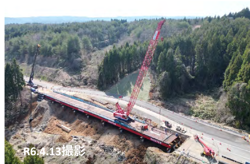
No.16付近 仮栈橋設置状況
