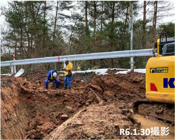
No.48詳細調査状況
