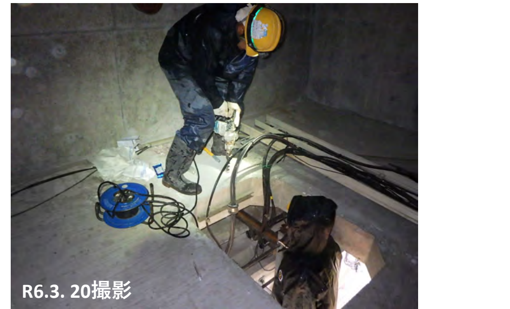
能登大橋 箱桁出入り口手掛け設置状況
