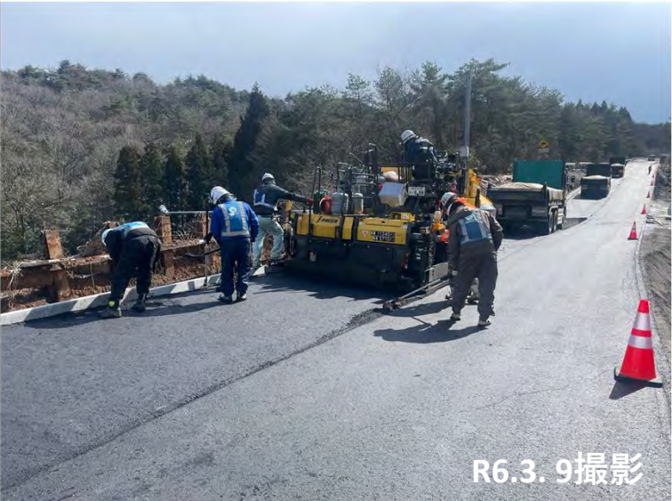
No. 45加熱合材施工状況
