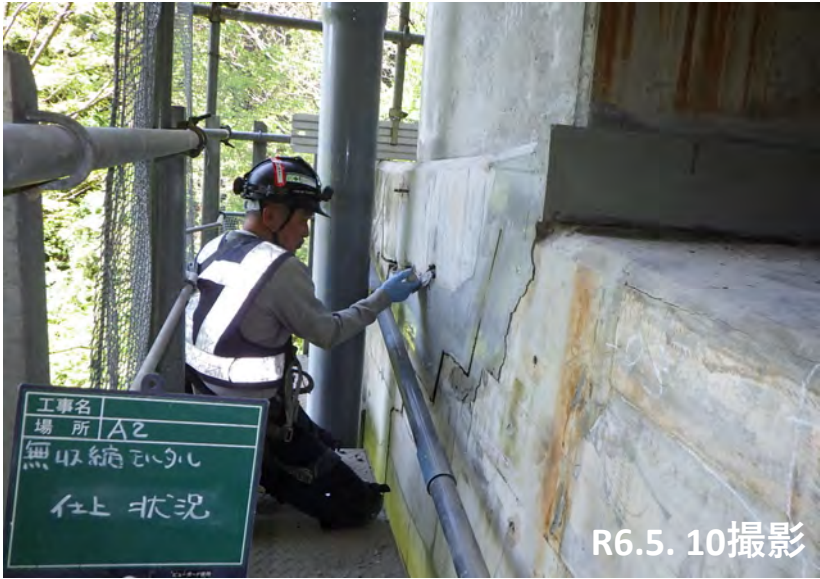
能登大橋・A2橋台(上り線側)地覆部断面修復状況
