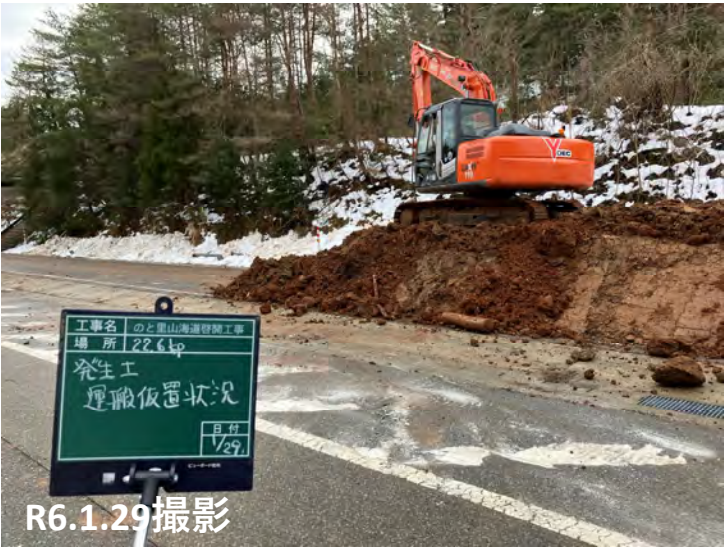
No.48～50詳細調査・残土処理状況
