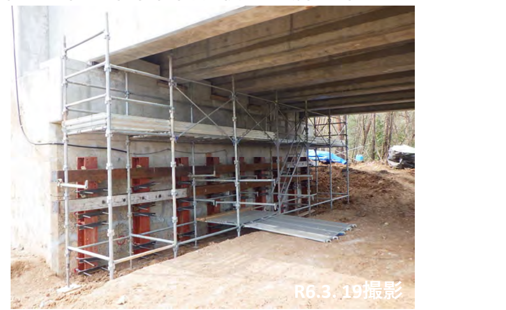
能登大橋 箱桁出入り口手掛け設置状況
