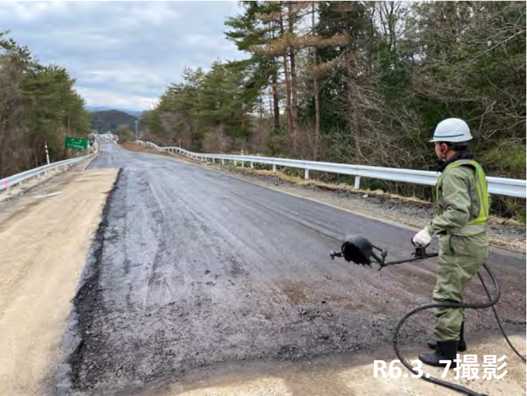
No. 45 舗装工乳剤散布施工状況
