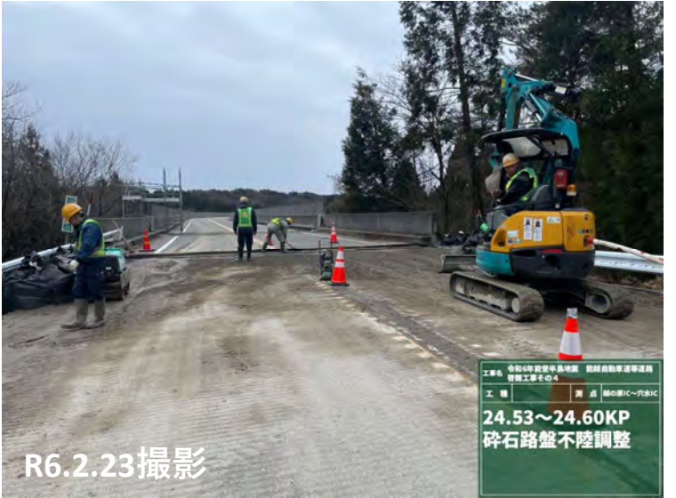
No. 56付近 碎石路盤不陸調整状況
