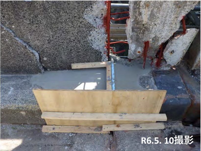
能登大橋・A2橋台(上り線側)地覆部断面修復状況
