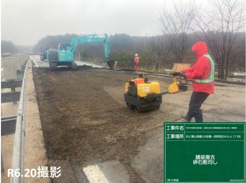
No.44 碎石敷均し状況
