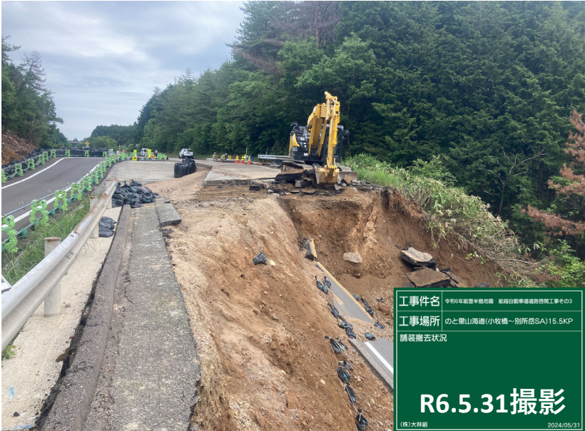
No.23付近 舗装撤去状況
