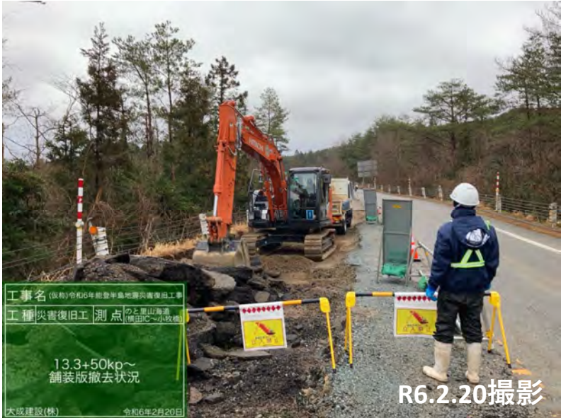
No.10 舗装撤去状況
