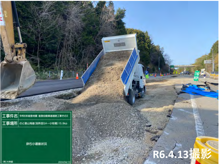
No.25付近 碎石小運搬状況
