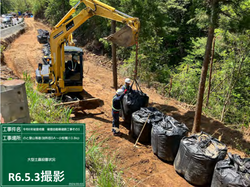
No.13 大型土嚢設置状況
