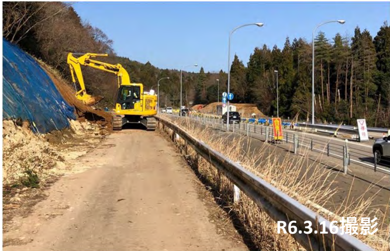
No.1付近 伐採作業状況
