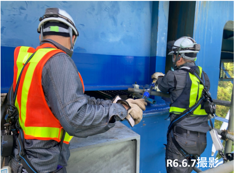
No.10 ピンチプレート交換状況
