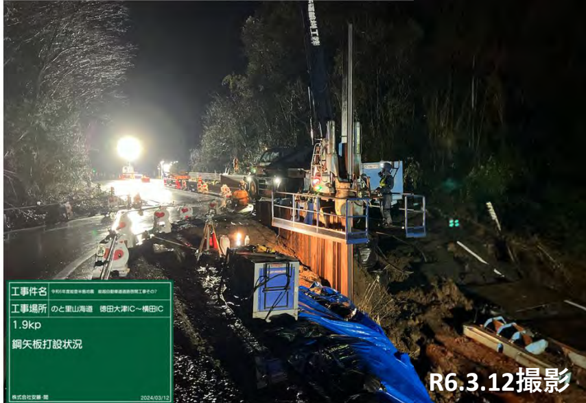
No. 2 鋼矢板打設状況
