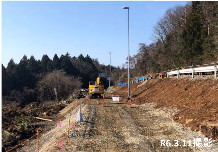
No.33 重機進入路造成状況
