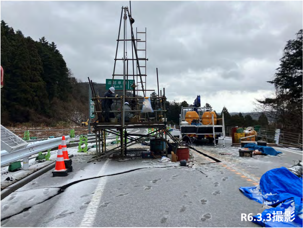
No.18 ボーリング調査状況
