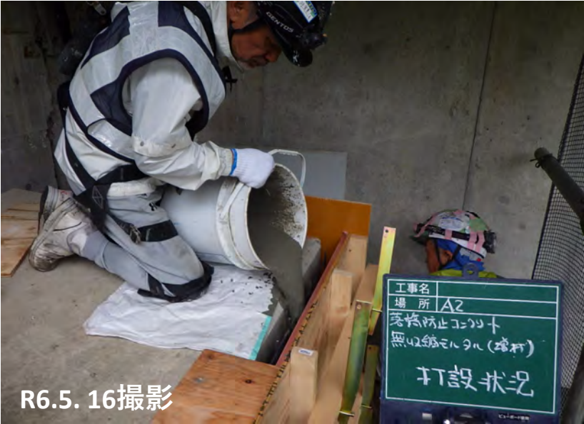
能登大橋・A2橋台 落橋防止断面修復状況
