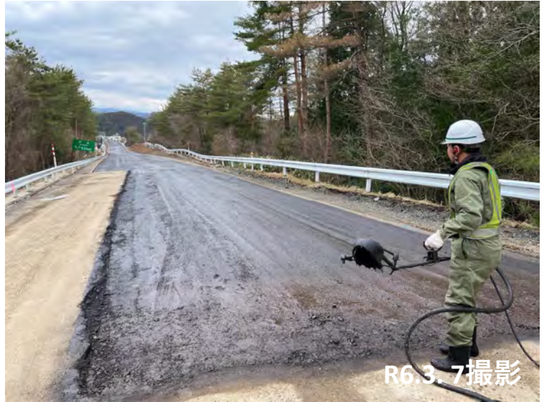
No. 45 舗装工乳剤散布施工状況
