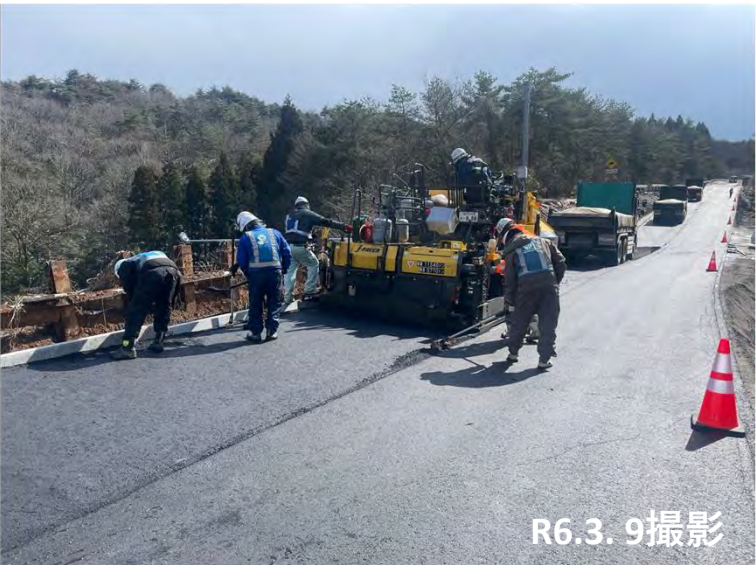
No. 45加熱合材施工状況
