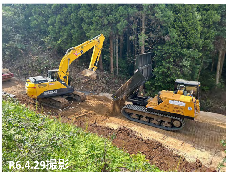
No.2付近 伐採材積込状況
