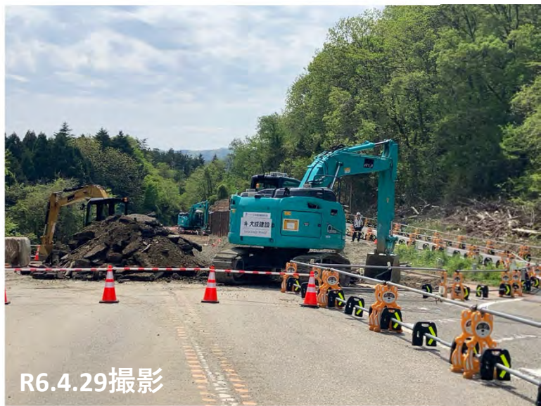
No.33 背面盛土、舗装撤去状況
