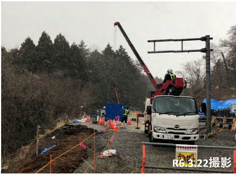
No.33 交通標識撤去状況
