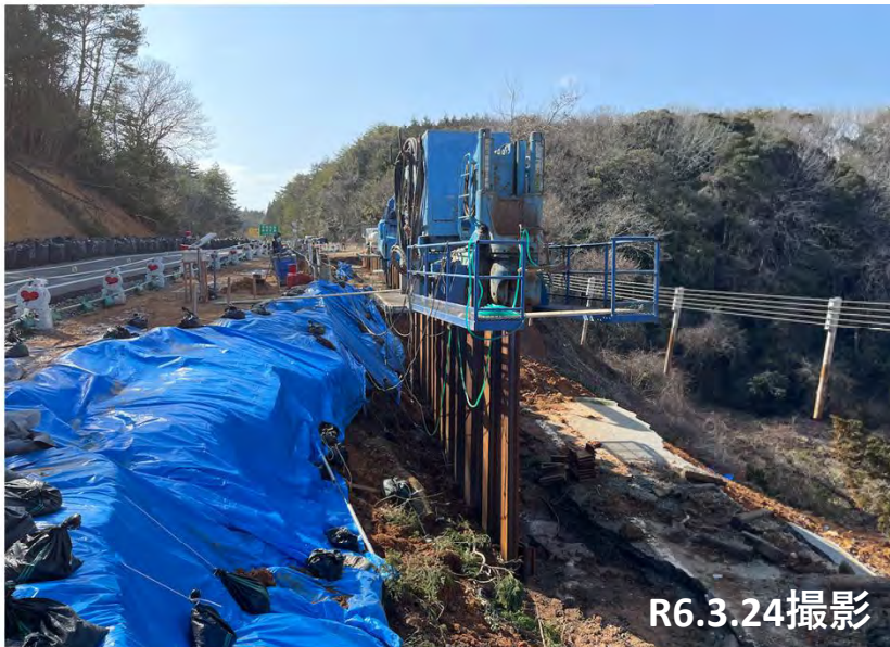
No. 5 鋼矢板圧入状況
