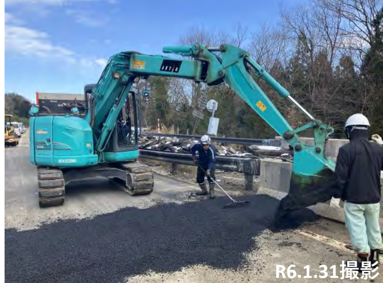
No32 舗装状況
