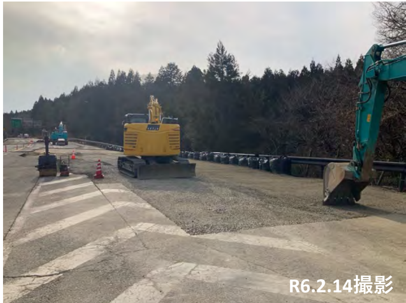
No.56 舗装撤去・砕石埋戻し
