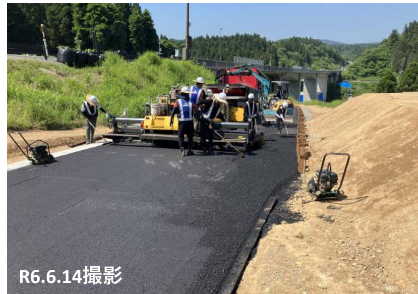
No.44付近 舗装工状況
