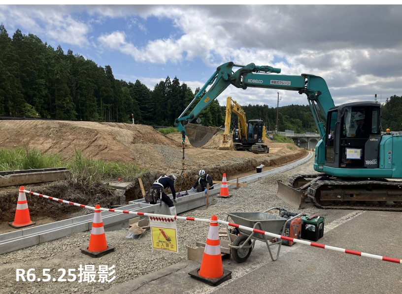
No.44付近 側溝設置状況
