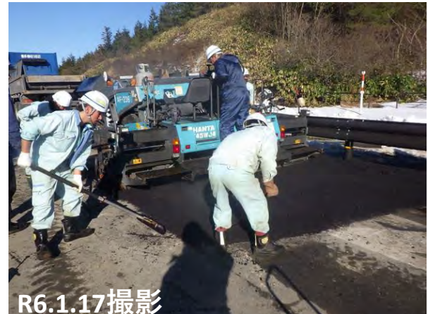
No.6 段差復旧状況
