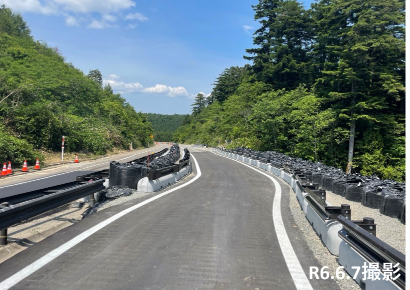
No.44付近 ガードレール設置状況
