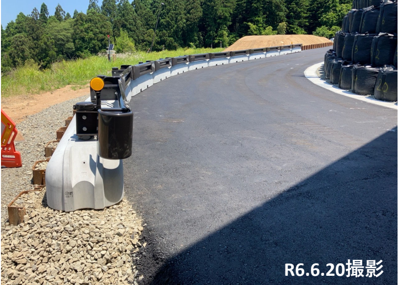
No.37付近 ガードレール設置状況
