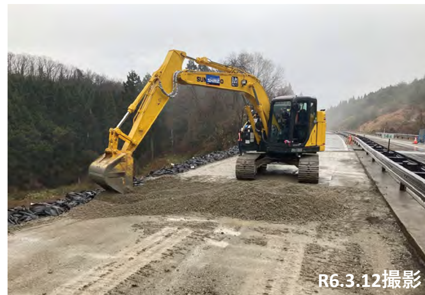
No.17 路盤材敷均し状況
