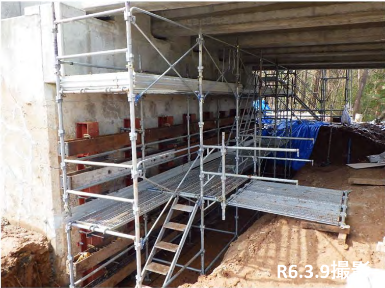
能登大橋 A1橋台足場組立状況
