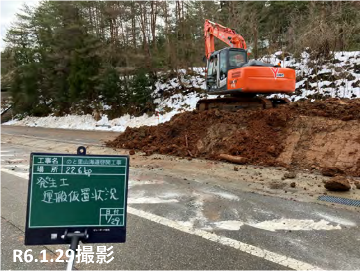
No.48～50詳細調査・残土処理状況
