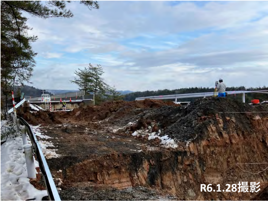
No.48測量状況
