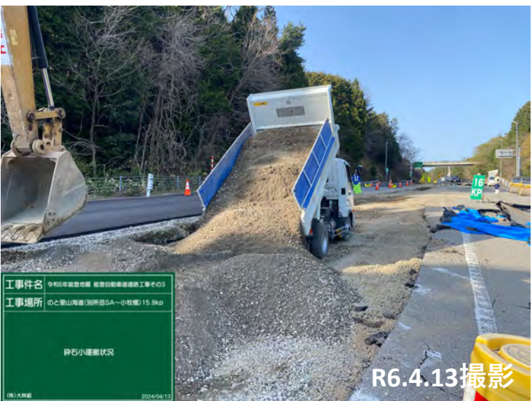
No.25付近 碎石小運搬状況
