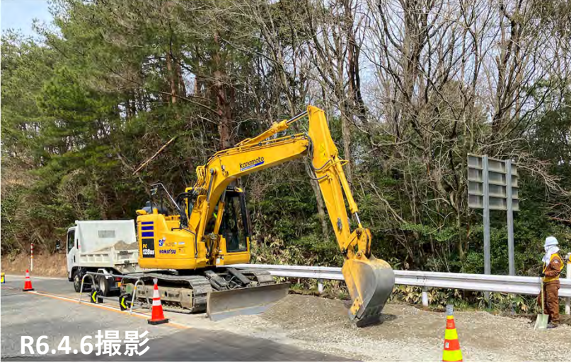
No.11 砕石敷均し状況
