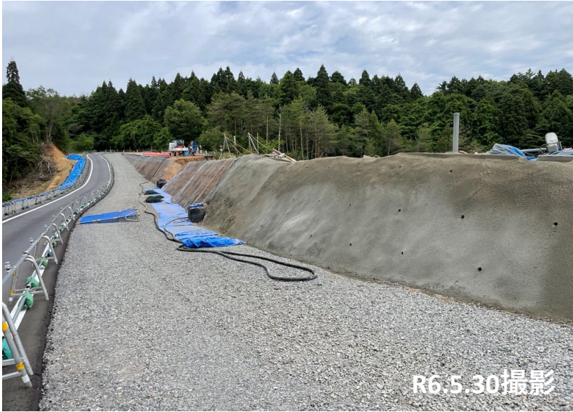
No.23付近 舗装撤去状況
