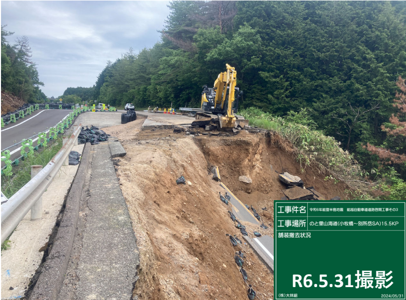
No.23付近 舗装撤去状況
