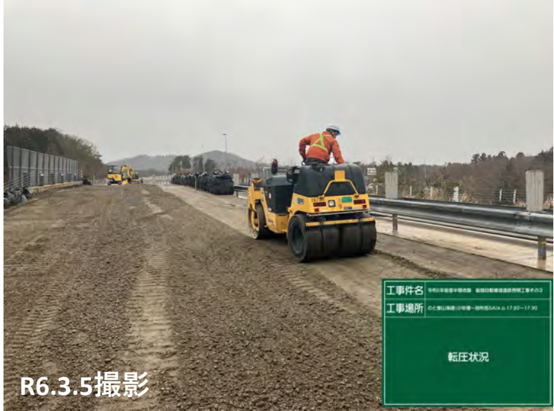
No.44 転圧状況
