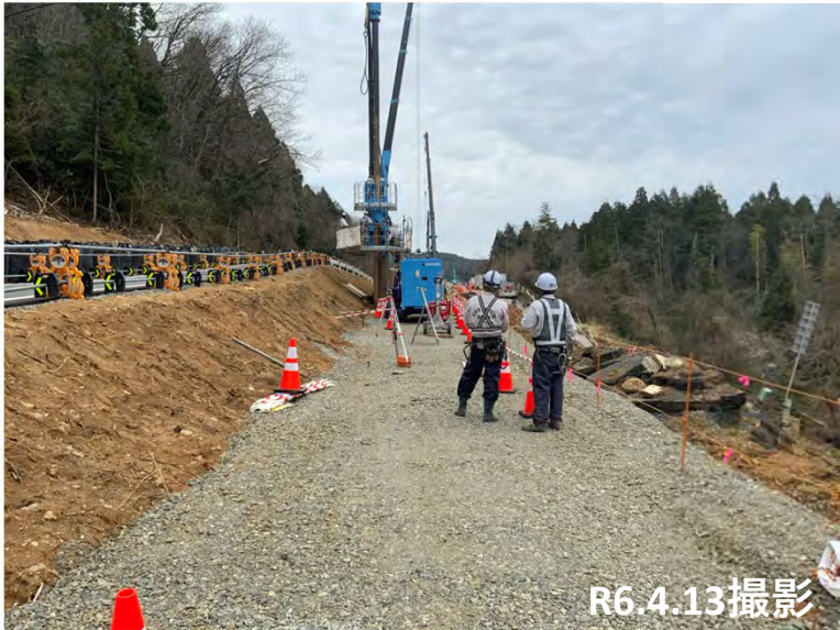
No.33付近 鋼矢板打設状況
