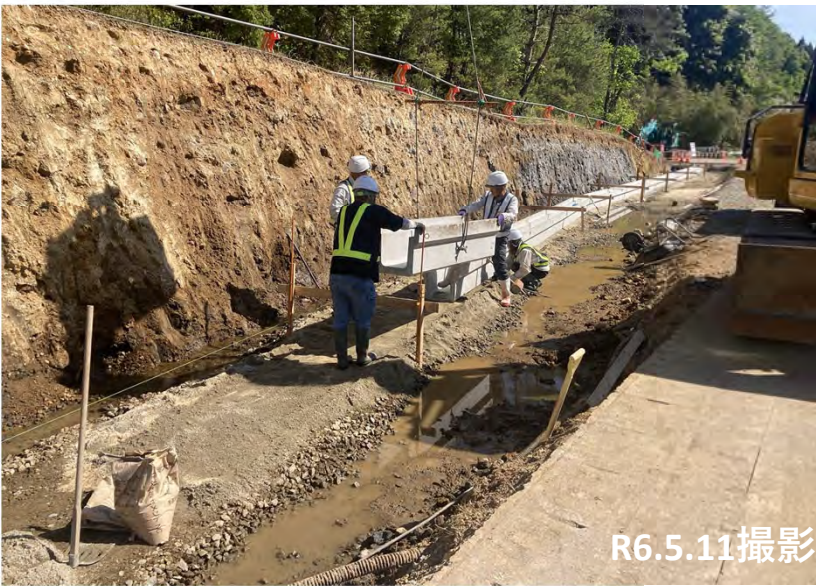
No.35 側溝設置状況
