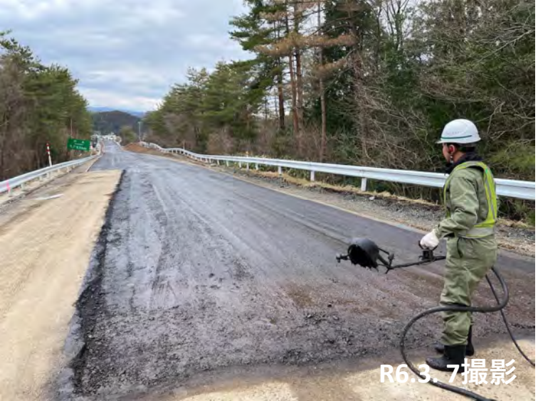
No. 45 舗装工乳剤散布施工状況
