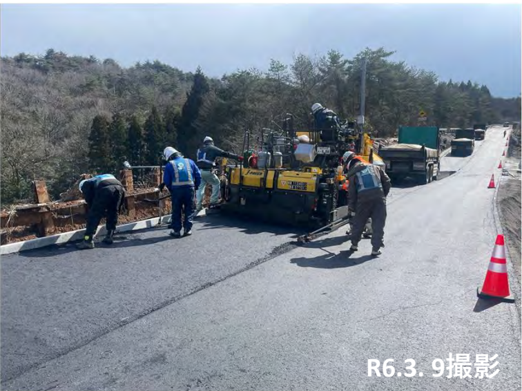
No. 45加熱合材施工状況
