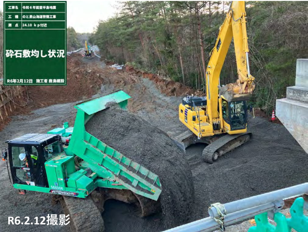
No. 49～52付近 碎石敷均し状況
