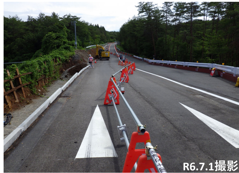
No.49付近 車線切替え状況
