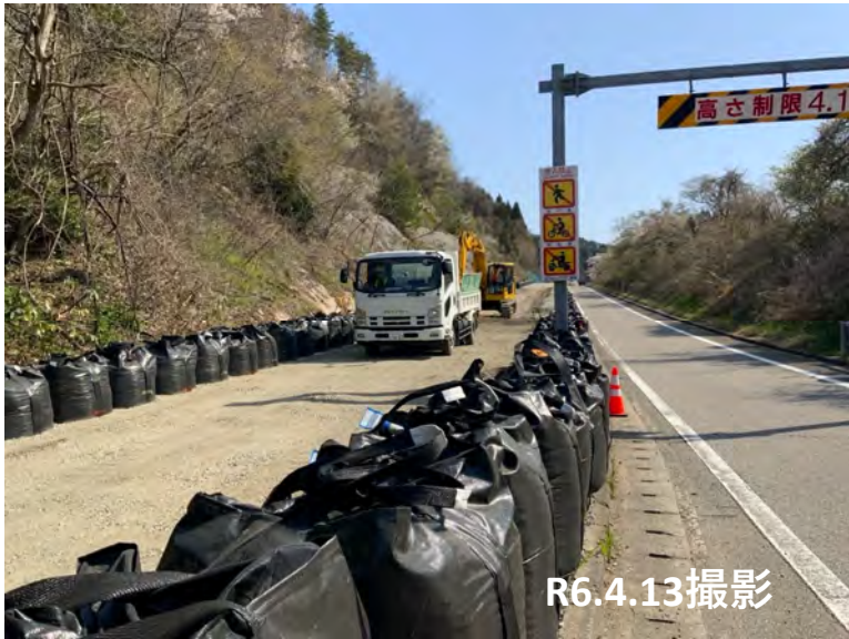
No.1付近 碎石敷均し状況
