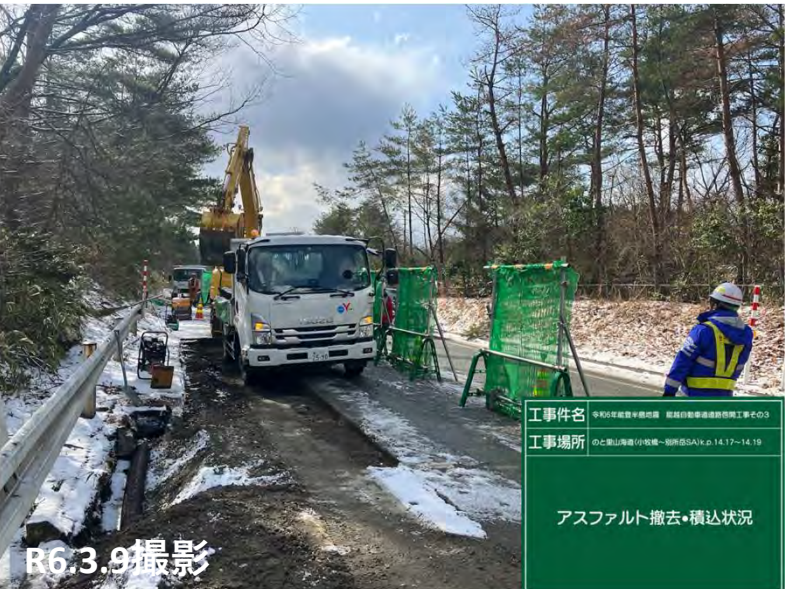
No.14 舗装撤去 積込運搬状況
