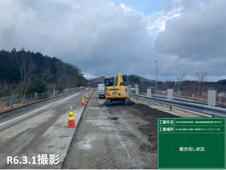
No.44 砕石敷均し状況
