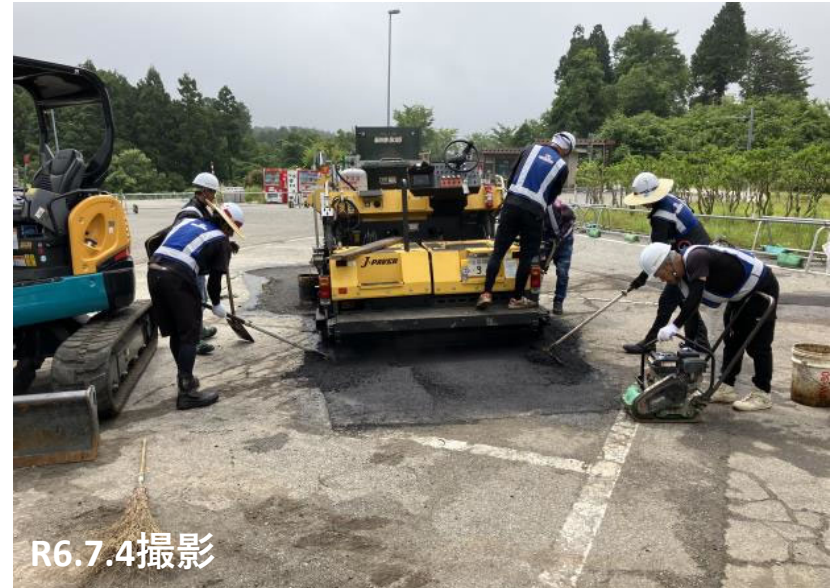
別所岳SA内 舗装工
