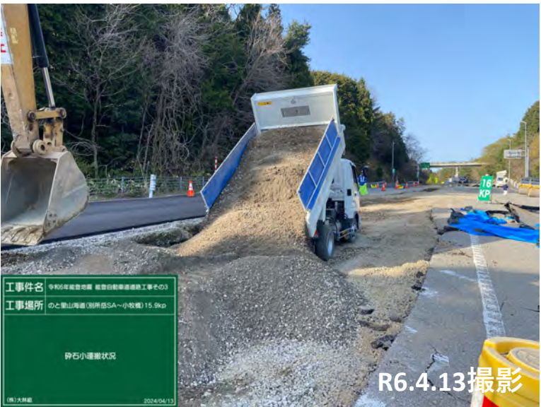
No.25付近 碎石小運搬状況
