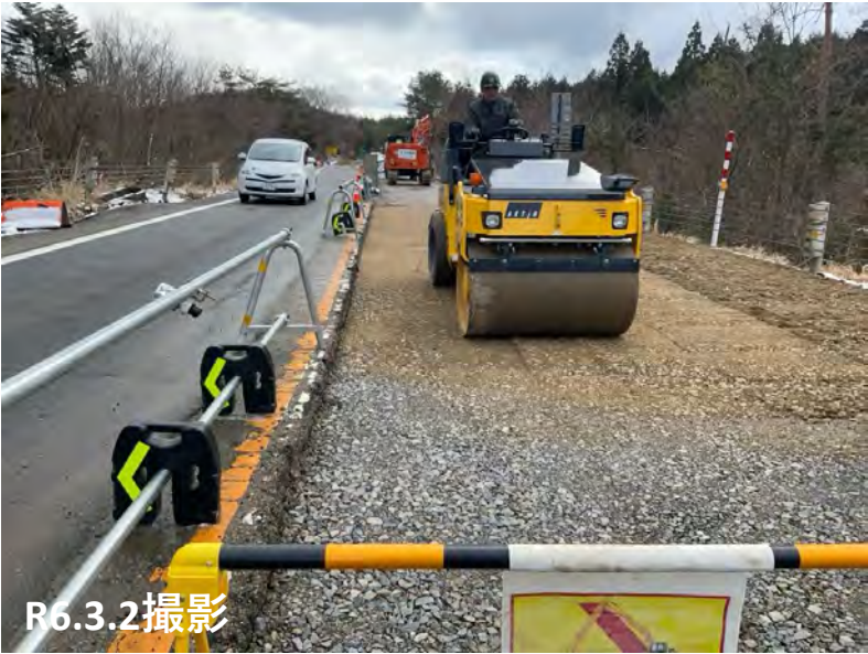
No.8付近 砕石転圧状況
