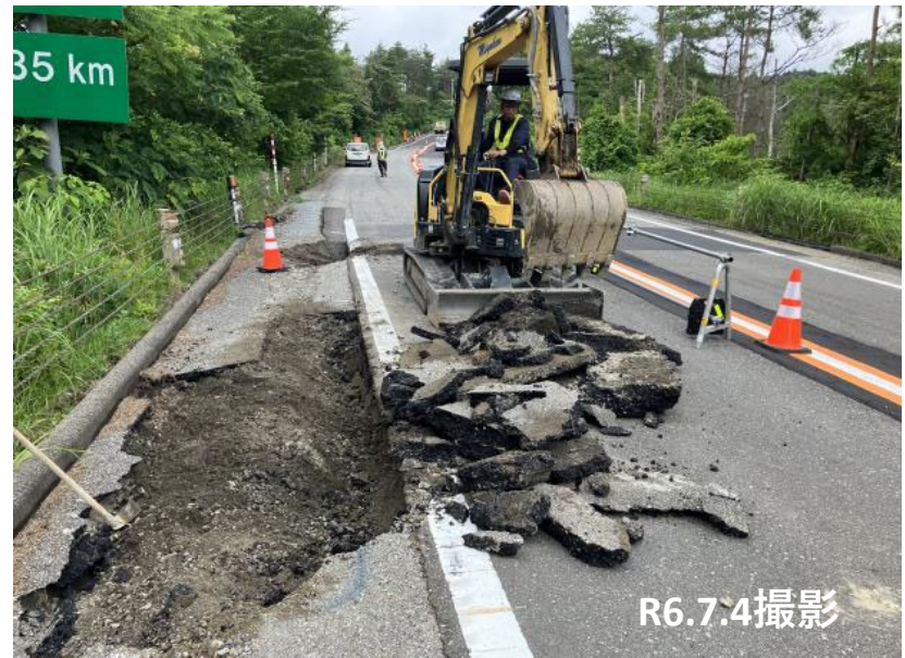
R6.7.4撮影 No.10 陥没部補修状況
