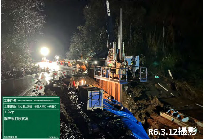
No. 2 鋼矢板打設状況
