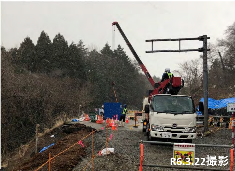
No.33 交通標識撤去状況
