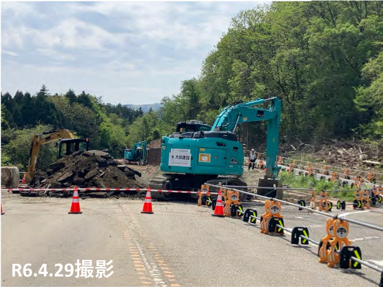
No.33 背面盛土、舗装撤去状況
