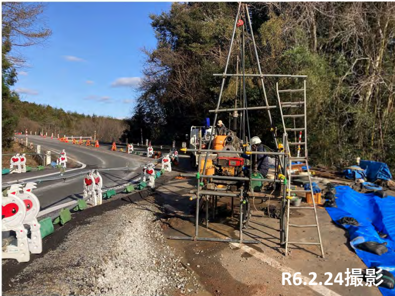
No.2 ボーリング調査状況
