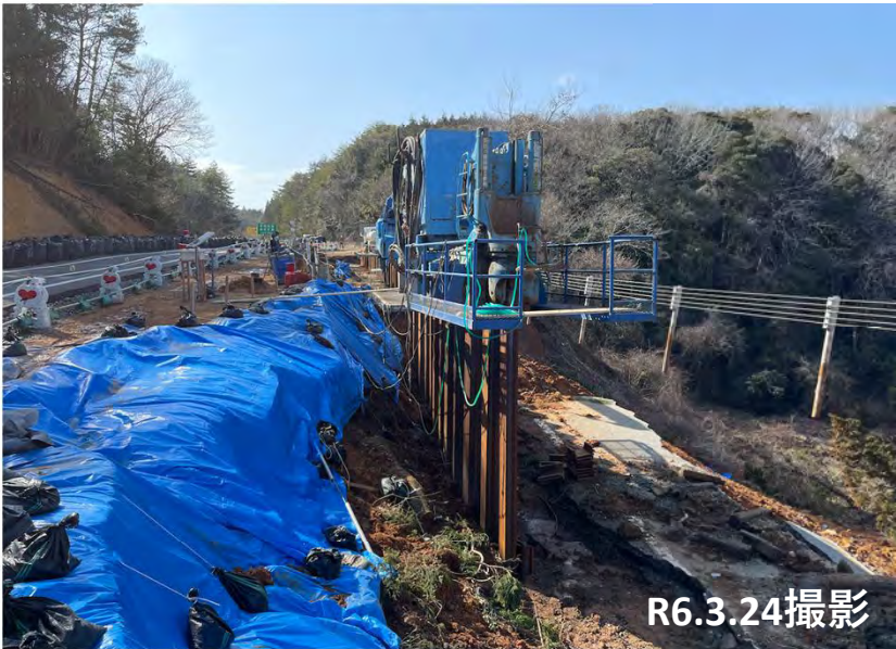
No. 5 鋼矢板圧入状況
