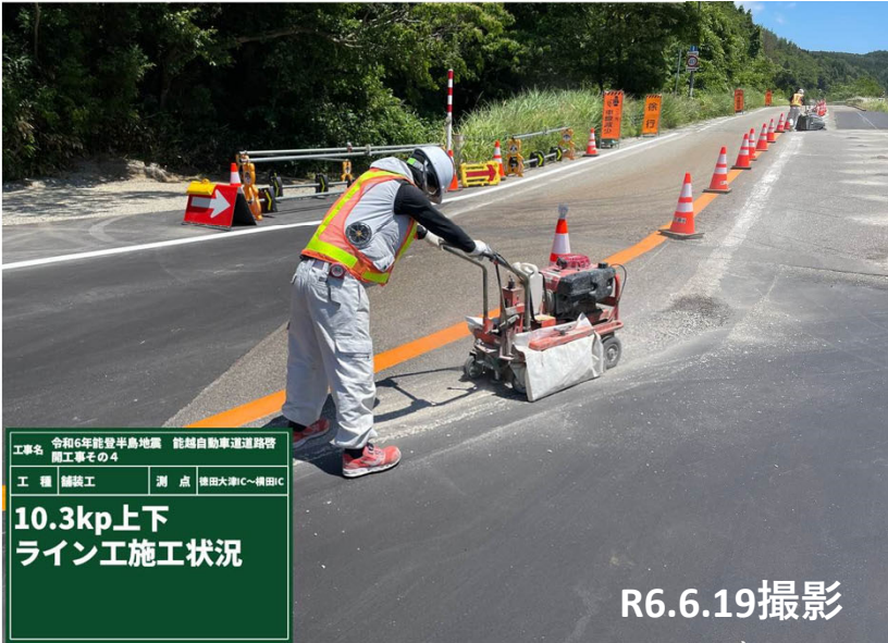
No.33 ライン工施工状況
