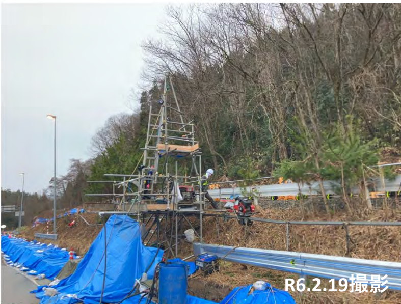
No.33 ボーリング調査状況
