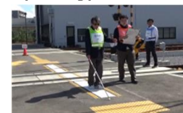
踏切道内誘導表示の整備
