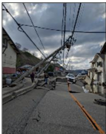
電柱等の倒壊
