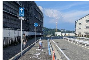
自転車道（大阪府茨木市）
