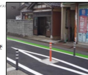
進入抑制対策の例 (ライジングボラード)
