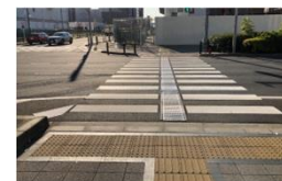
視覚障害者誘導用 ブロックの整備
