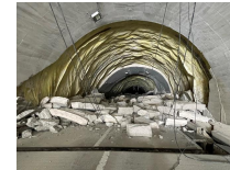
▲国道249号大谷トンネル
