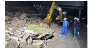
▲24時間体制での道路啓開作業
