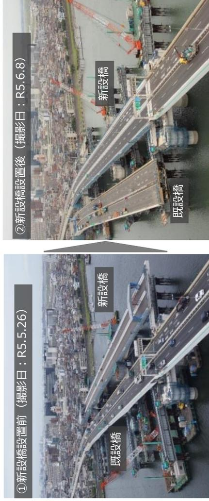
延長約300mの新設橋を既設橋の位置へ移動して架設
