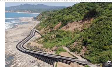
海岸隆起を活用し緊急車両・地元車両の通行を確保（国道249号千枚田工区）
