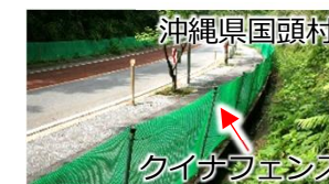
クイナフェンス ヤンバルクイナの ロードキル対策事例
