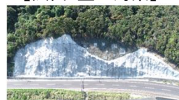
法面吹付工、落石防止網工
