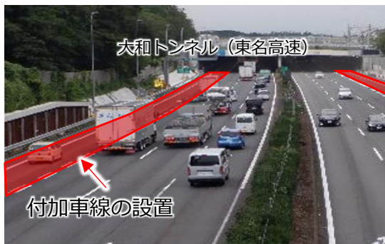
付加車線の設置 ボトルネック対策 (付加車線の設置)
