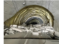
▲国道249号大谷トンネル
