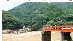
令和2年7月豪雨...熊本県道
