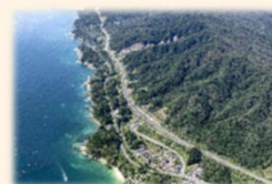
三陸沿岸道路（岩手県山田町）
