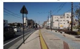
歩道の拡幅・ 段差、傾斜、勾配の改善
