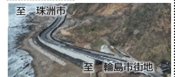
海岸隆起を活用し通行を確保(国道249号千枚田工区)
