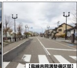
【電線共同溝整備区間】
