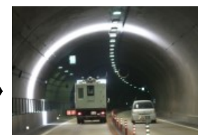
画像計測状況
