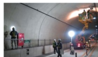
点検状況（トンネル点検車使用）
