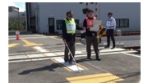
踏切道内誘導表示の整備
