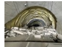
▲国道249号大谷トンネル
