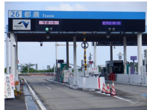
東九州自動車道 都農料金所 出口（宮崎県）
