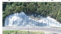
法面吹付工、落石防止網工
