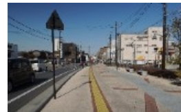
歩道の拡幅・ 段差、傾斜、勾配の改善
