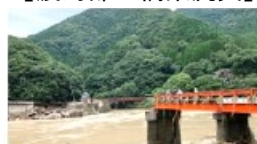
令和2年7月豪雨...熊本県道
