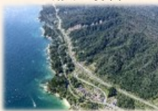
三陸沿岸道路（岩手県山田町）
