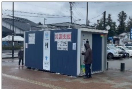
トイレコンテナ
