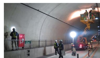
点検状況（トンネル点検車使用）
