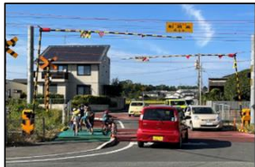
踏切道の拡幅
