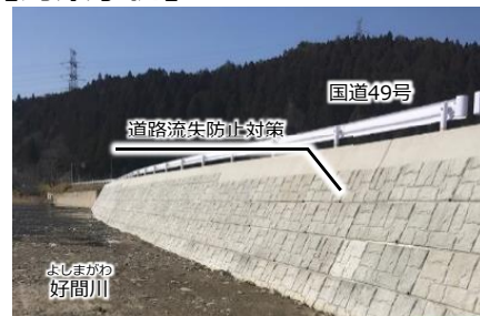
国道49号流失対策（福島県いわき市）
