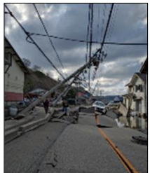
電柱等の倒壊
