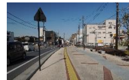
歩道の拡幅・段差、傾斜、勾配の改善
