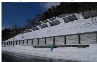
雪崩対策の例（雪崩防止柵）
