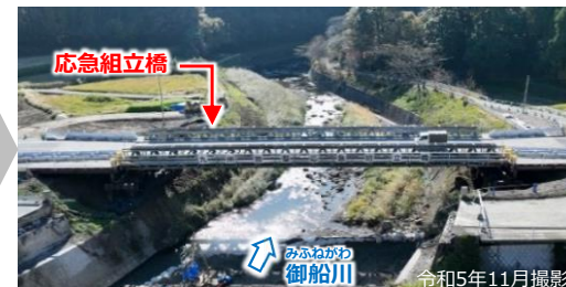
応急組立橋架設後の状況
