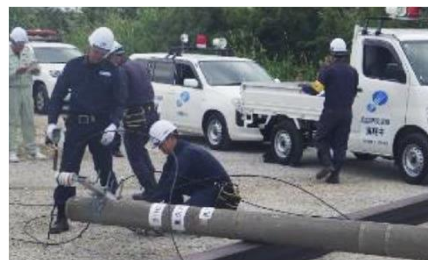
倒壊電柱の除去訓練
