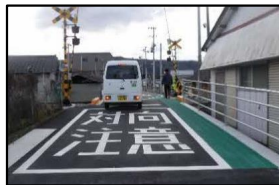
カラー舗装、路面標示
