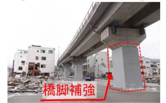
耐震補強例（金石高架橋）
