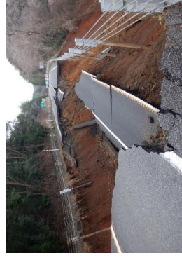
R6能登半島地震による盛土崩落状況
