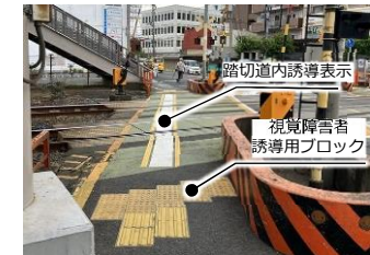
踏切道内誘導表示の設置
