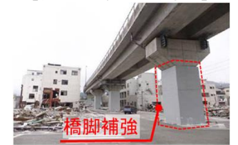
耐震補強例（釜石高架橋）
