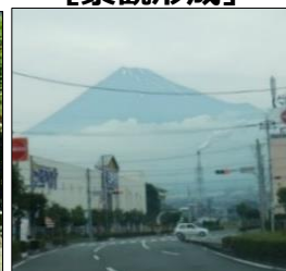
電線類による景観阻害
