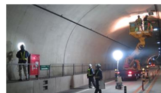
点検状況（トンネル点検車使用）
