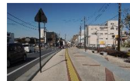
歩道の拡幅・段差、傾斜、勾配の改善
