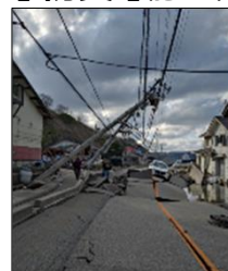
電柱等の倒壊
