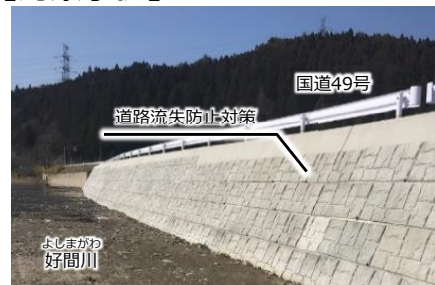
国道49号流失対策（福島県いわき市）
