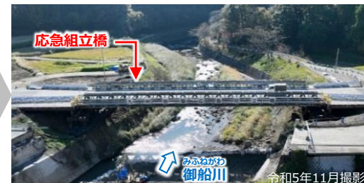
応急組立橋架設後の状況
