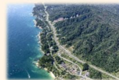
三陸沿岸道路（岩手県山田町）
