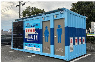
道の駅「塩津海道あぢかまの里」：運用中
