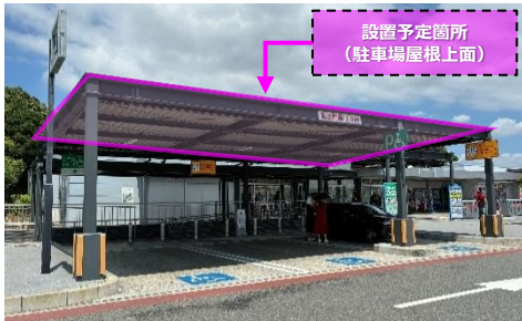
ペロブスカイト太陽電池現場実証 (NEXCO西日本 名神高速道路 桂川PA)
