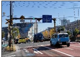
カラー舗装、路面標示
