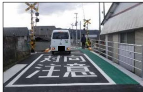
踏切道の歩道設置
