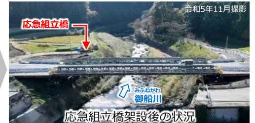
応急組立橋架設後の状況
