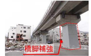
耐震補強例(釜石高架橋)
