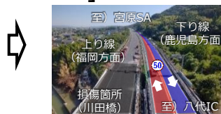
応急復旧完了（対面通行）
