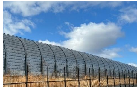
更なる導入拡大に向けた検討箇所例 (高速道路の遮音壁)
