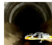
ドローンによる目視調査
