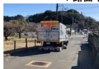
（空洞探査車による調査）
