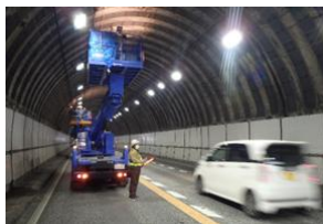
点検状況（トンネル点検車使用）
