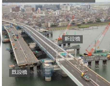
②新設橋設置後（撮影日：R5.6.8）
