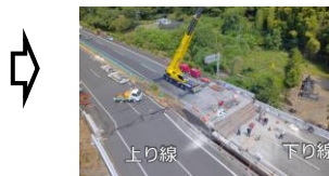
応急復旧作業中（下り線）
