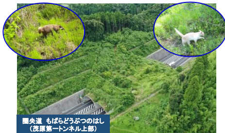
トンネル上部を樹林化
