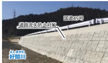
国道49号流失対策 (福島県いわき市)
