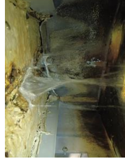
①トンネル内の漏水 ②鉄筋一部消失 ③コンクリートの損傷
