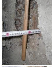
①トンネル内の漏水 ②鉄筋一部消失 ③コンクリートの損傷
