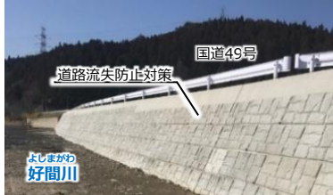
国道49号流失対策 (福島県いわき市)
