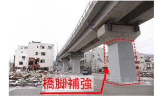
耐震補強例(釜石高架橋)
