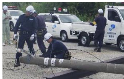
倒壊電柱の除去訓練
