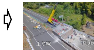
応急復旧作業中（下り線）
