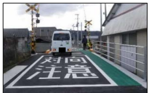
踏切道の歩道設置
