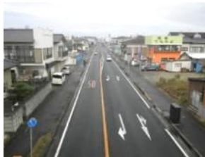
国道6号 (茨城県高萩市)
