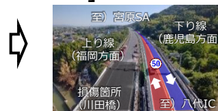
応急復旧完了（対面通行）
