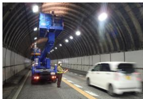
点検状況（トンネル点検車使用）
