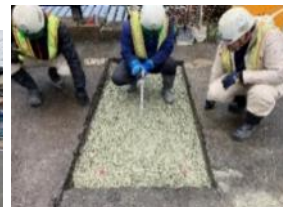
空洞補修工事
