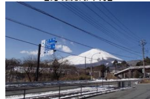
電線類による景観阻害
