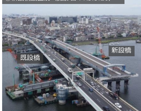
①新設橋設置前（撮影日：R5.5.26）
