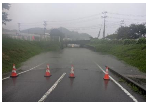
市道沼田・馬場線米田アンダーボックス（福島県いわき市）
