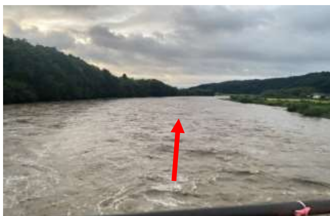
【令和6年8月三箇橋 さん が ばし 下流 出水状況】
