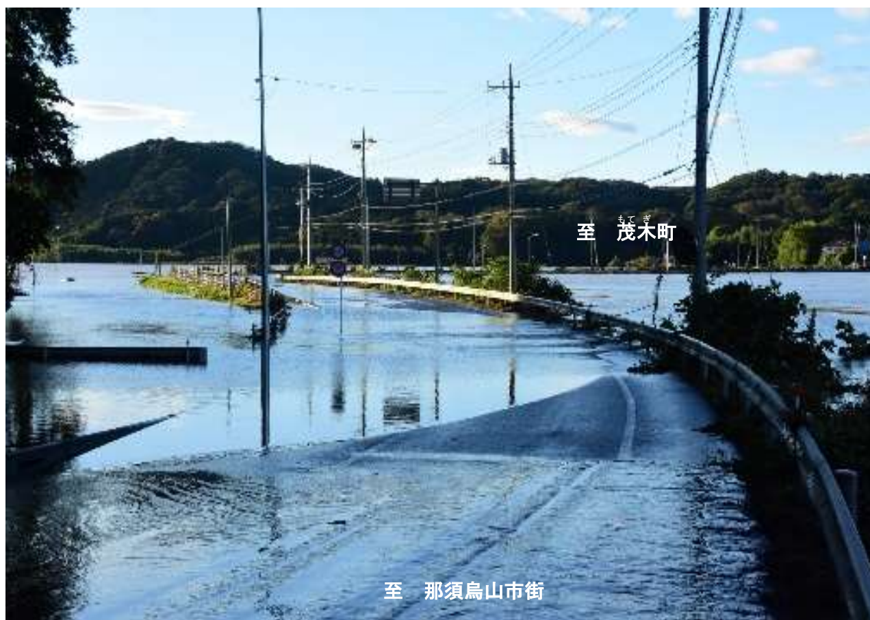
令和元年東日本台風による冠水通行止め(R元.10.13 (国)294号 那須烏山市 むかた 向田)
