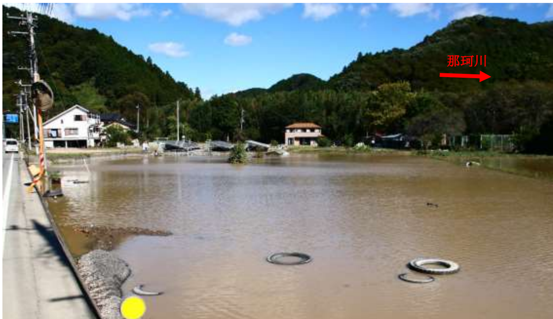
② 令和元年 10 月 13 日 県道那須 烏 山御前山線 冠水状況 みやばら 宮 原 地区
