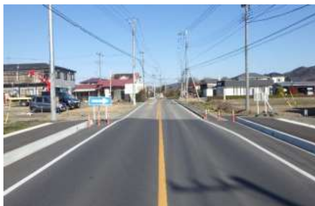
【現在の進捗状況】
