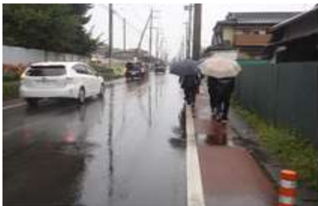
【歩道やセンターラインがなく危険な状況】
