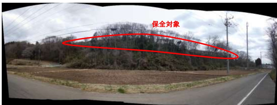
【小滝田 I A (急傾斜崩壊対策事業) の保全対象全景】
