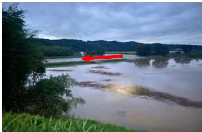
【令和6年8月藤田橋 ふじ た ばし 上流 出水状況】
