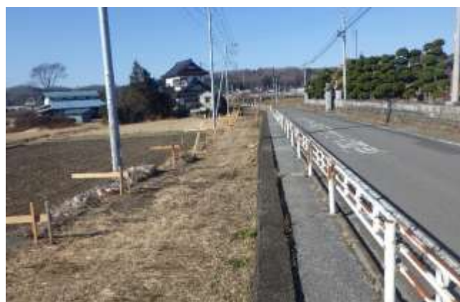
【現在の進捗状況】
