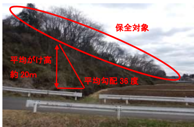
【小滝田 I A (急傾斜崩壊対策事業) の全景】
