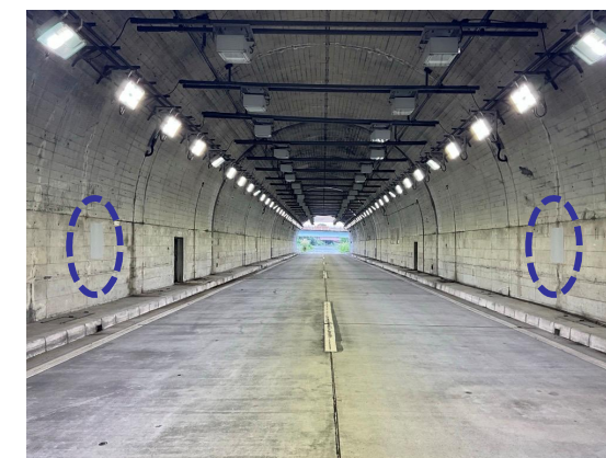
直線部反射体設置状況
