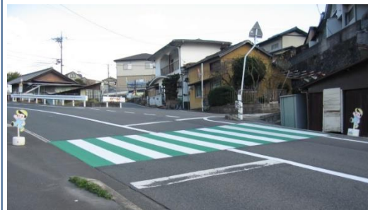
図-2 横断歩道カラー舗装（1回目）
