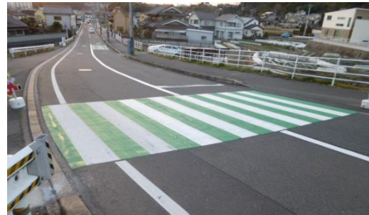
図-5 横断歩道カラー舗装（2回目）
