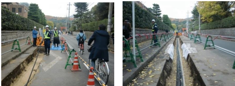
図-2 ケーブル敷設状況
