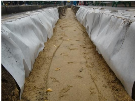
図-3 土木用透水シート設置区間
