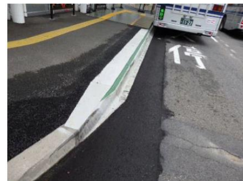
バリアレス縁石の状況
