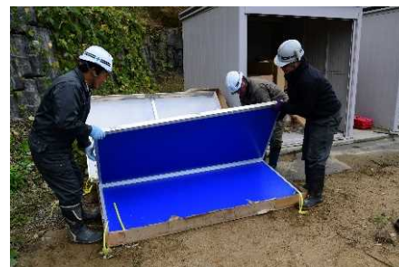
防災トイレ組立て状況
