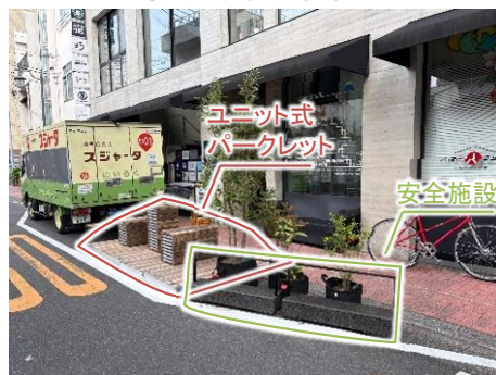
写真3: ユニット式パークレット設置状況
