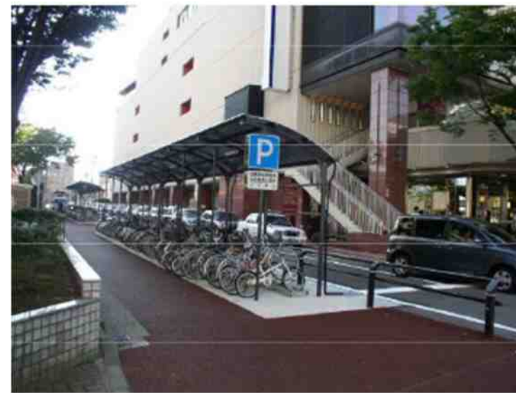
路上のパーキングメーターを撤去した駐輪場 (新潟県新潟市) 写真出典： https://www.mlit.go.jp/common/001002220.pdf
