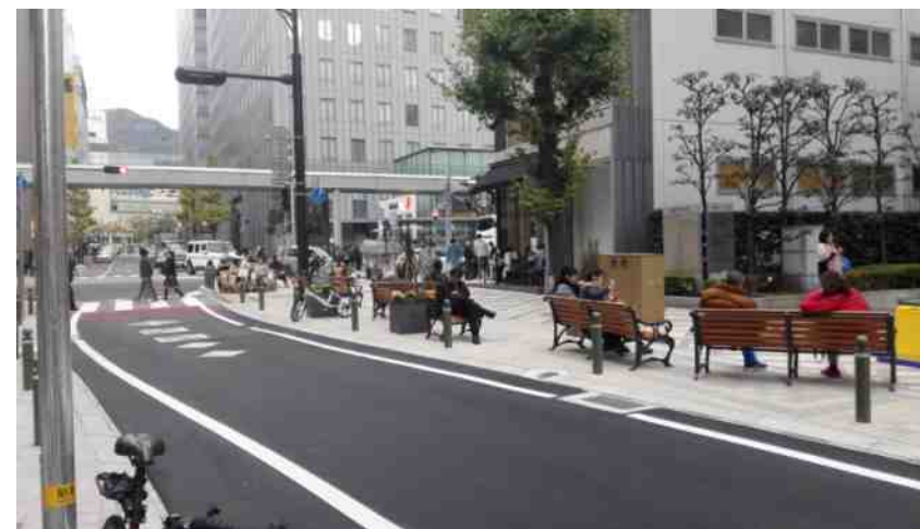
葺合南54号線歩道を拡幅しベンチを設置（兵庫県神戸市） 写真出典：
