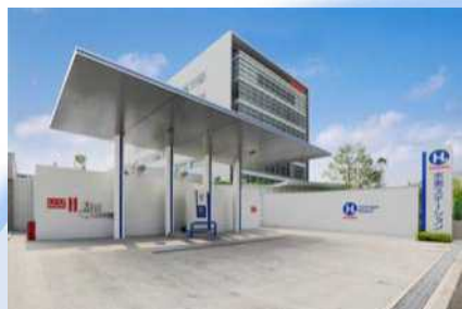
<水素ステーション>
