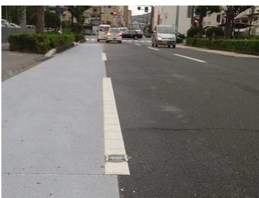
写真Ⅱ-8 道路標示「車両通行帯」を凹凸のついた仕様とした事例
