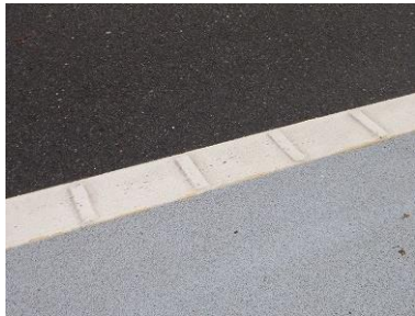
写真Ⅱ-8 道路標示「車両通行帯」を凹凸のついた仕様とした事例
