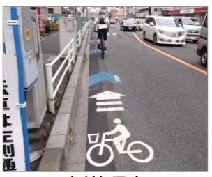
車道混在 (矢羽根型路面表示)
