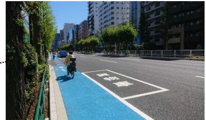
都道301号(白山通り) ※自転車通行帯の車道側に停車帯を設置
