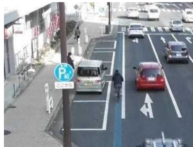
【停車帯と自転車専用通行帯の併設事例(北九州市)】
