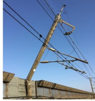
電柱の折損
